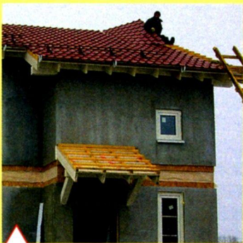
Укладка металлической черепицы
