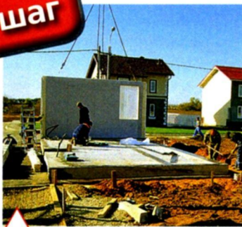
Монтаж первой стеновой панели
