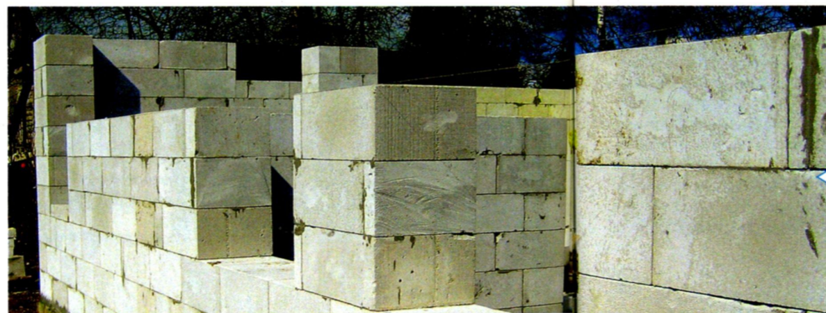
Дом из газобетонных блоков на железобетонном каркасе (ф. RDI, архитектор – Тотаи Кузембаев)
