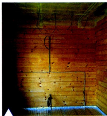
Инженерная подготовка влажной зоны
