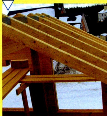
Стропильная конструкция скатной крыши
