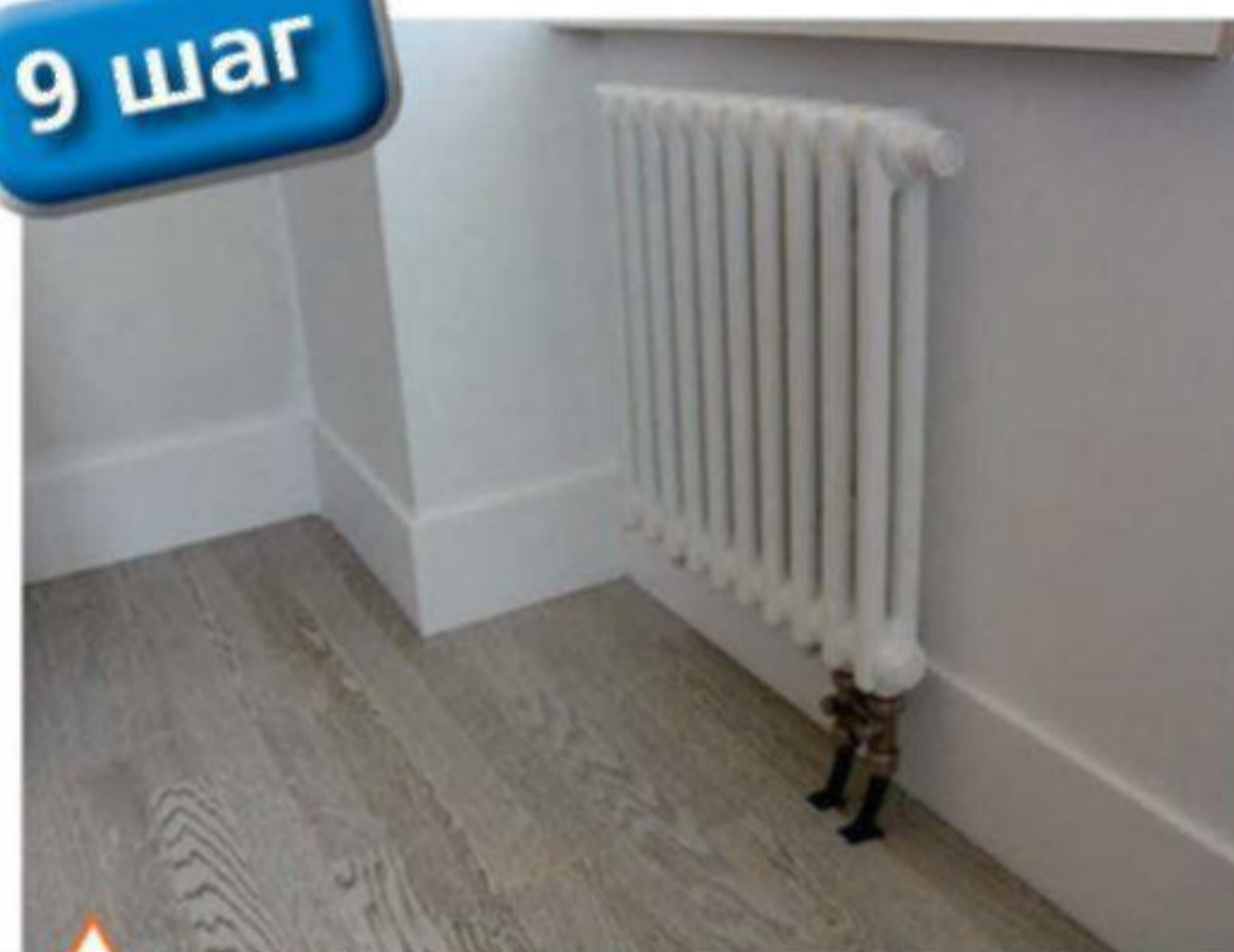
Скрытая радиаторная разводка, уложенная в толще чернового пола
