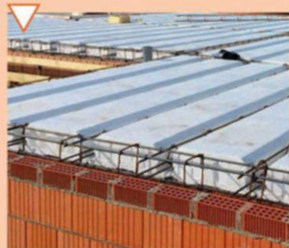
Сборно-монолитное перекрытие первого этажа
