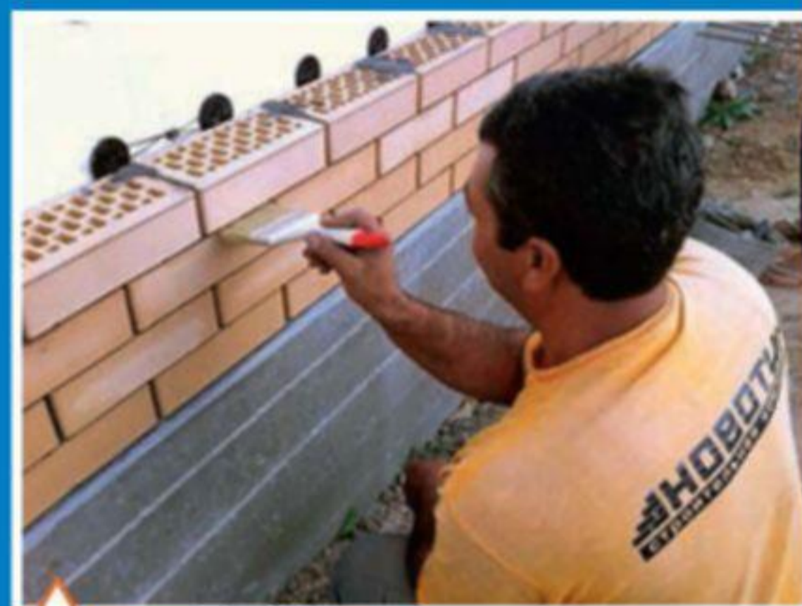
Обработка швов кирпичной облицовки
