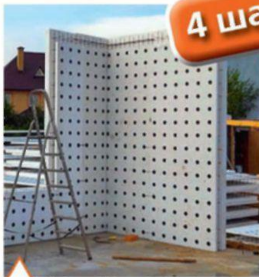
Монтаж несъемной опалубки из пенополистирольных панелей
