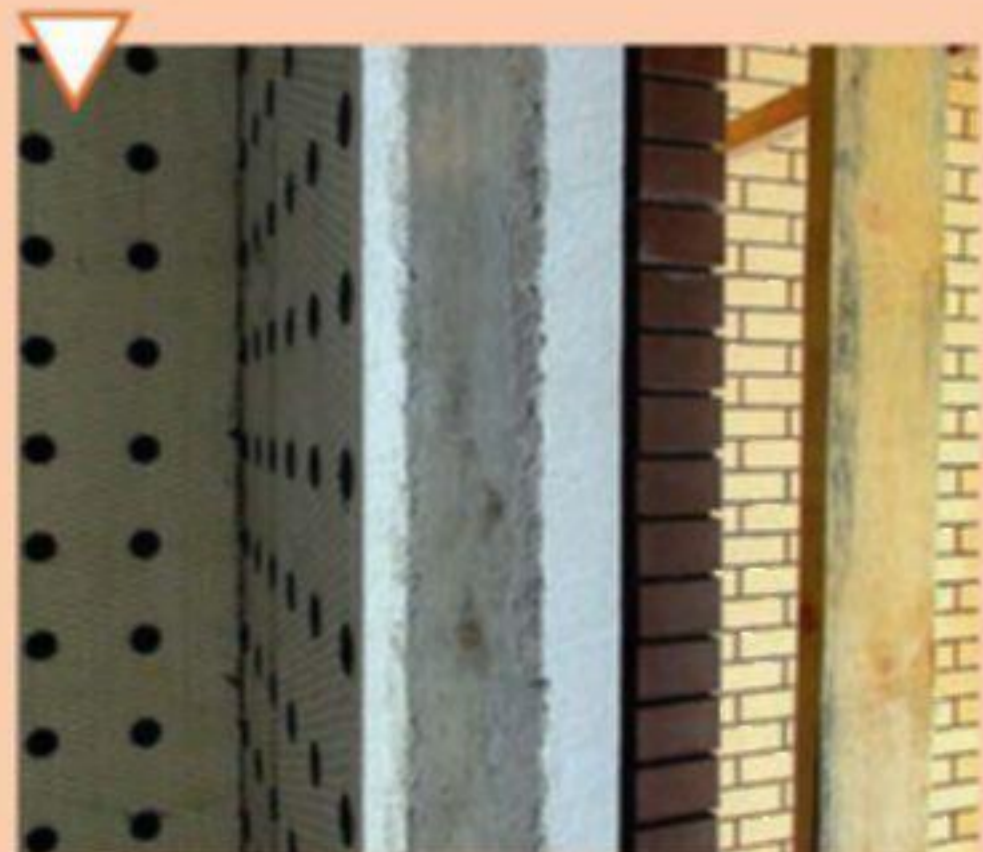
Структура стены на базе полистирольной несъемной опалубки
