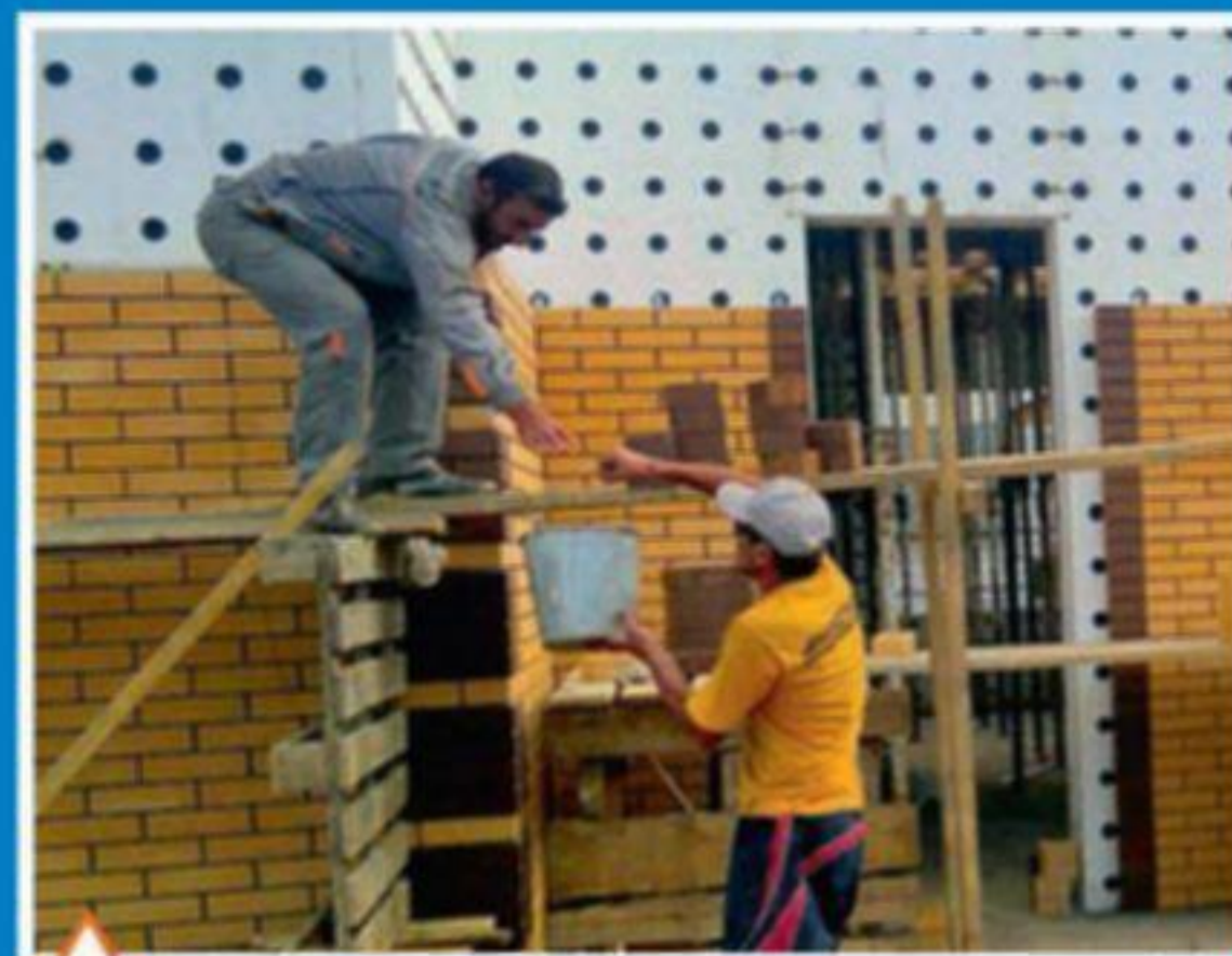
Возведение фасадной стенки из лицевого кирпича двух цветов
