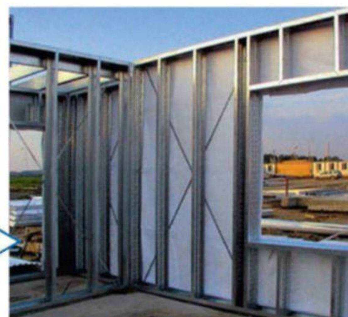
Дом на каркасе из термопрофилей (ф. С.О.В.А)
