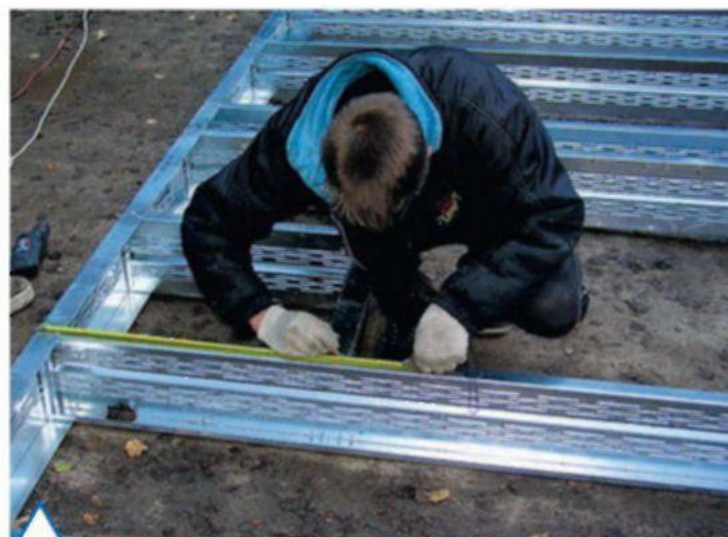
Начало сборки каркаса из термопрофилей
