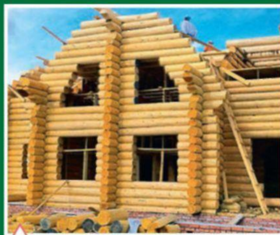
Сруб собран и готов к возведению стропильной конструкции крыши
