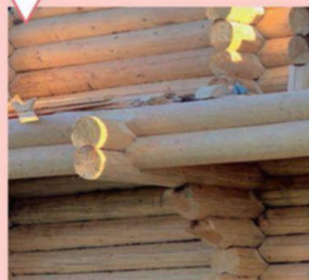
Вид стен после обработки стыков
