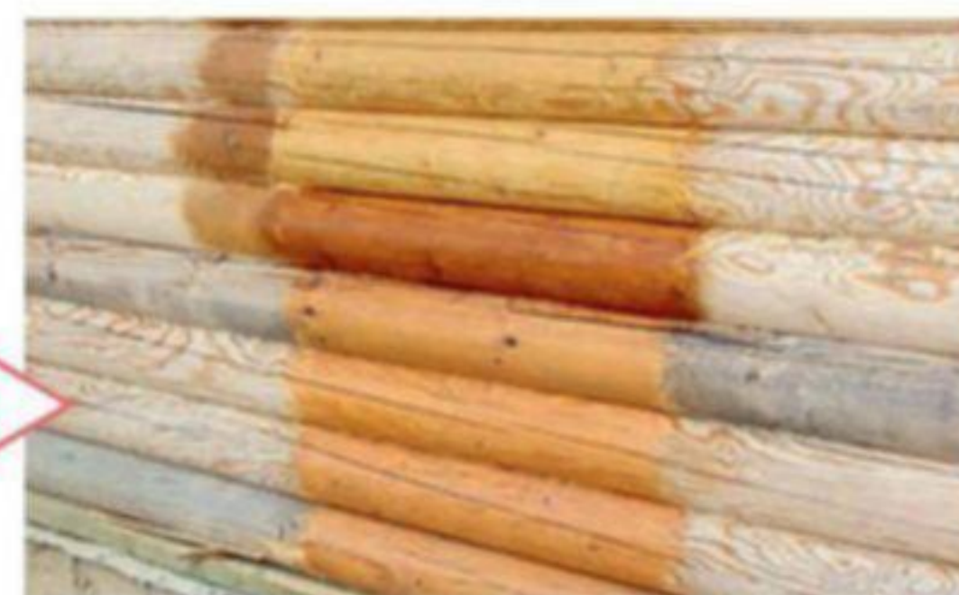
Нанесение на бревенчатые стены лессирующего антисептика на водной основе
