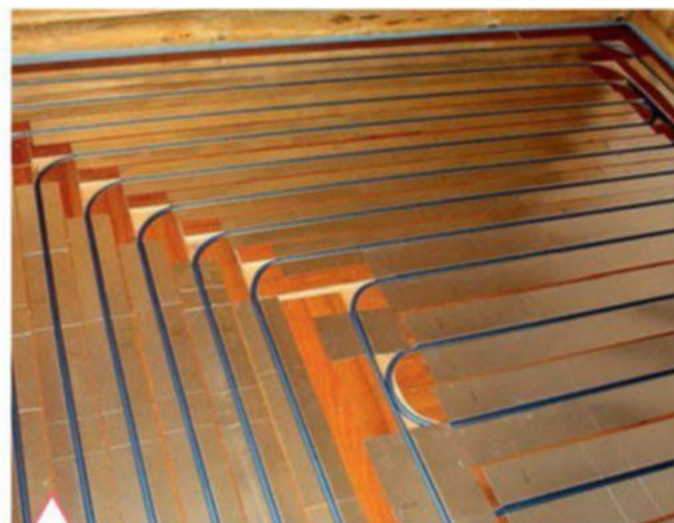
Устройство системы водяного напольного отопления на первом этаже дома
