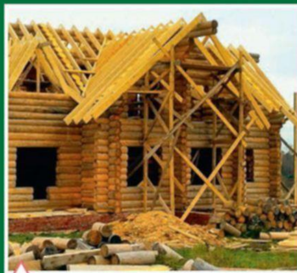
Стропильная конструкция крыши
