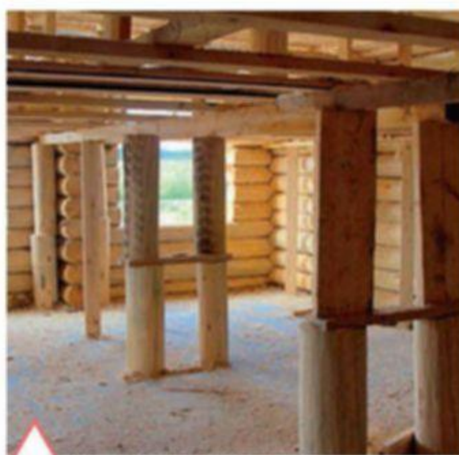
Монтаж межэтажного перекрытия
