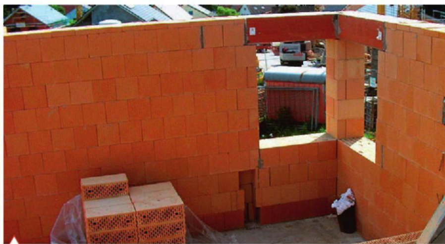
Строительство дома из керамических блоков
