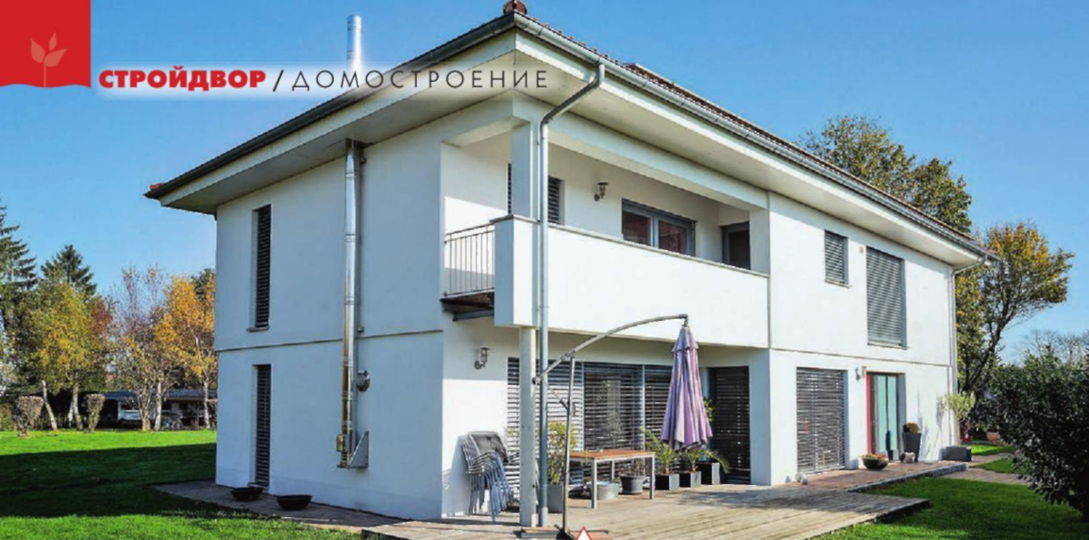
Дом из керамических блоков подведен под крышу
