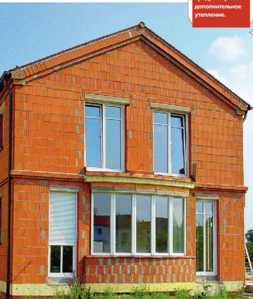
Дом из керамических блоков перед финишной отделкой
