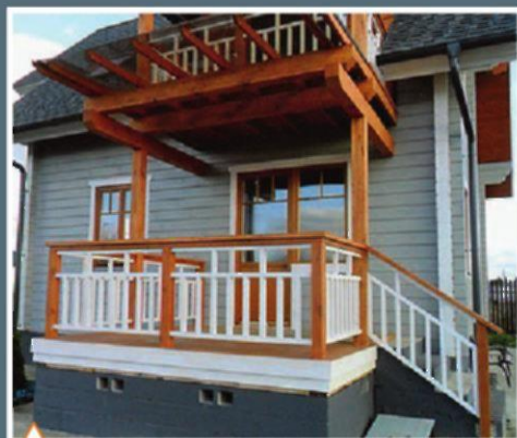
Прозрачный козырек над широкой отмосткой
