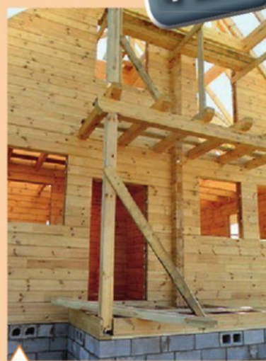
Сооружение балкона и открытой террасы (она же крыльцо у главного входа)
