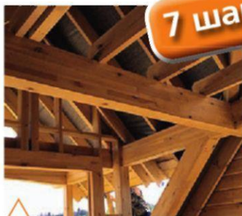
Вид стропильной крыши изнутри дома
