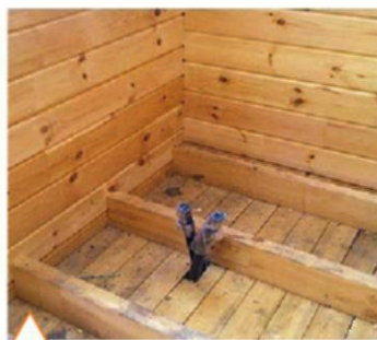
Ввод инженерных коммуникаций непосредственно в дом
