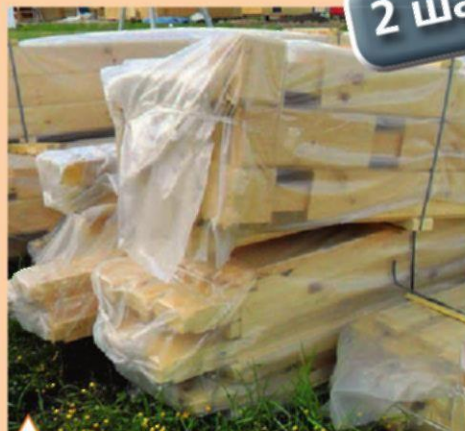
Доставленные на участок элементы домокомплекта, упакованные в прочный полиэтилен и стянутые полипропиленовой лентой
