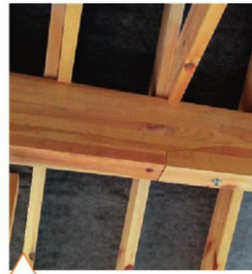
Стык составного прогона (продольной слеги)
