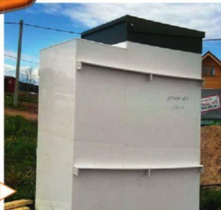
Очистная установка «ТОПАС 8» перед монтажом в грунт
