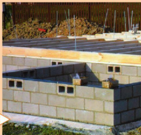
Цоколь из пескоцементных блоков и балочное деревянное перекрытие техподполья
