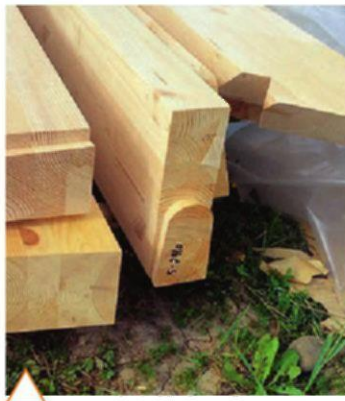
Распакованные элементы стропильной группы
