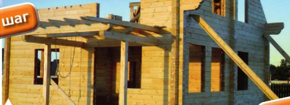
Собранный сруб дома (стены, перегородки и междуэтажное перекрытие)
