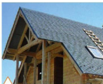
Кровельное покрытие из битумной черепицы, имитирующей натуральный камень
