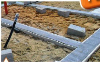
Горизонтальная гидроизоляция по обрезу фундамента
