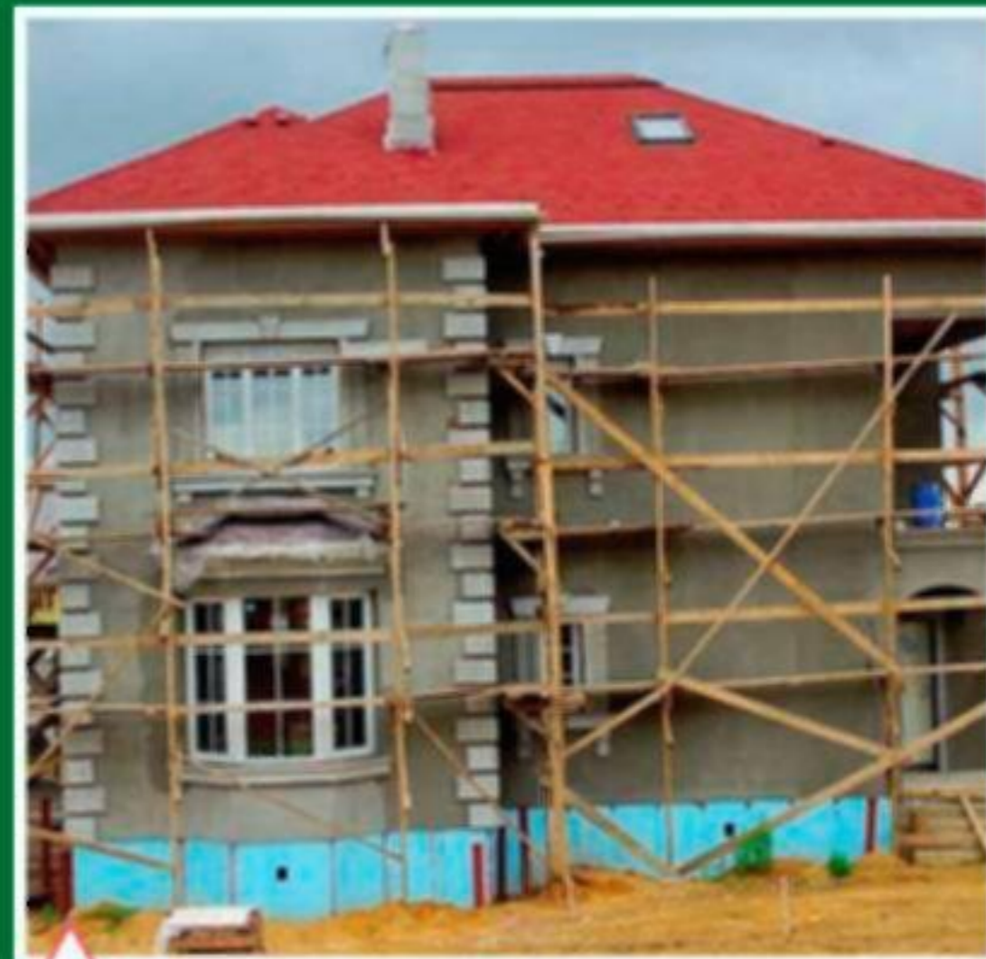
Наружные стены оштукатурены под покраску
