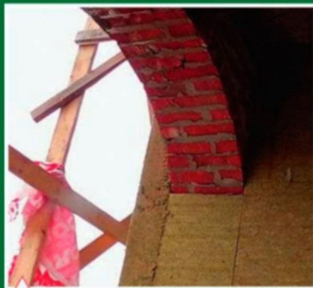
Утепление фасадов теплоизоляционными плитами из базальтовой ваты
