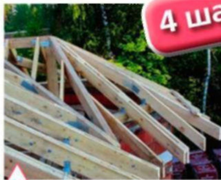
Вид стропильной конструкции скатной крыши
