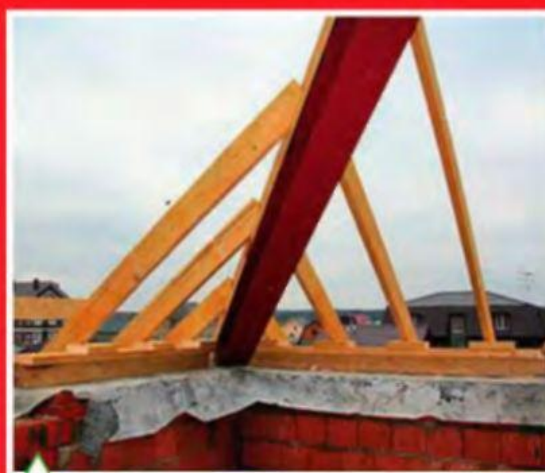
Несущие металлические элементы стропильной конструкции скатной крыши
