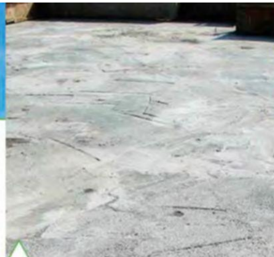
Монолитная железобетонная фундаментная плита
