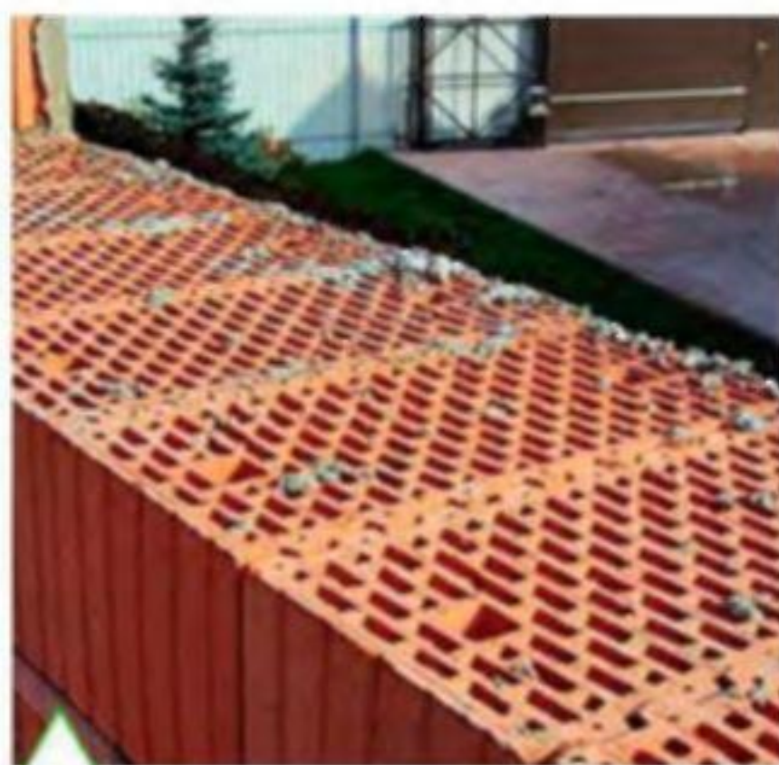
Кладка стен из поризованных керамических камней (блоков)
