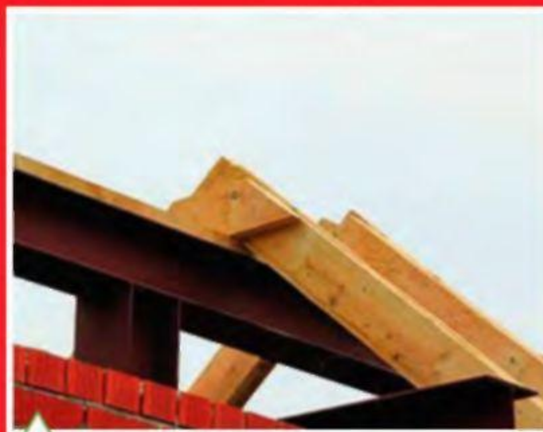
Устройство конькового узла стропильной конструкции
