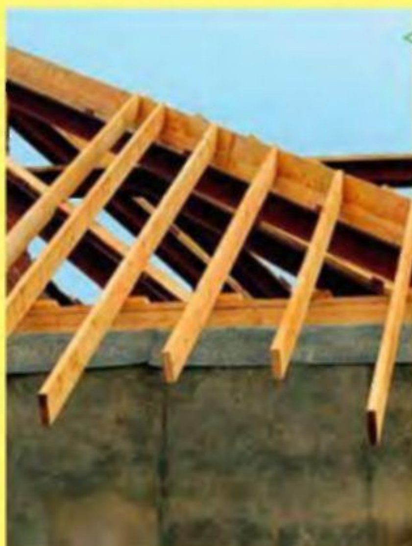
Опирающие деревянные стропила на кирпичную стену
