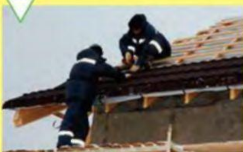
Укладка кровельного покрытия – композитной черепицы Metrofile
