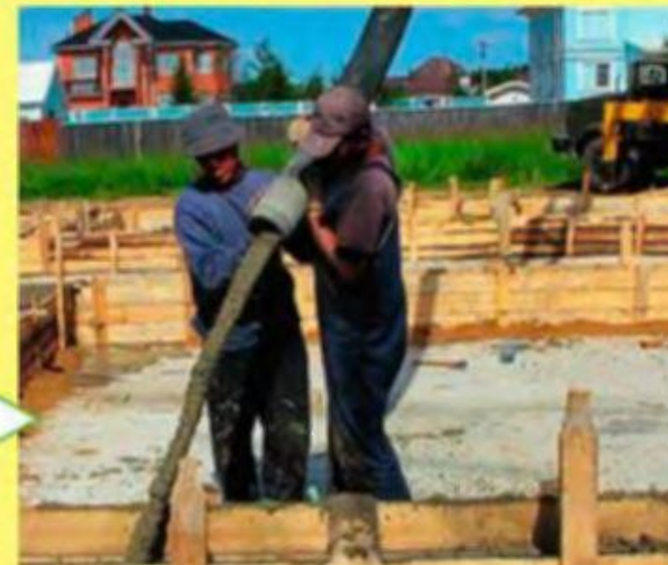
Подготовка опалубки стен технического подполья к заливке бетонной смеси
