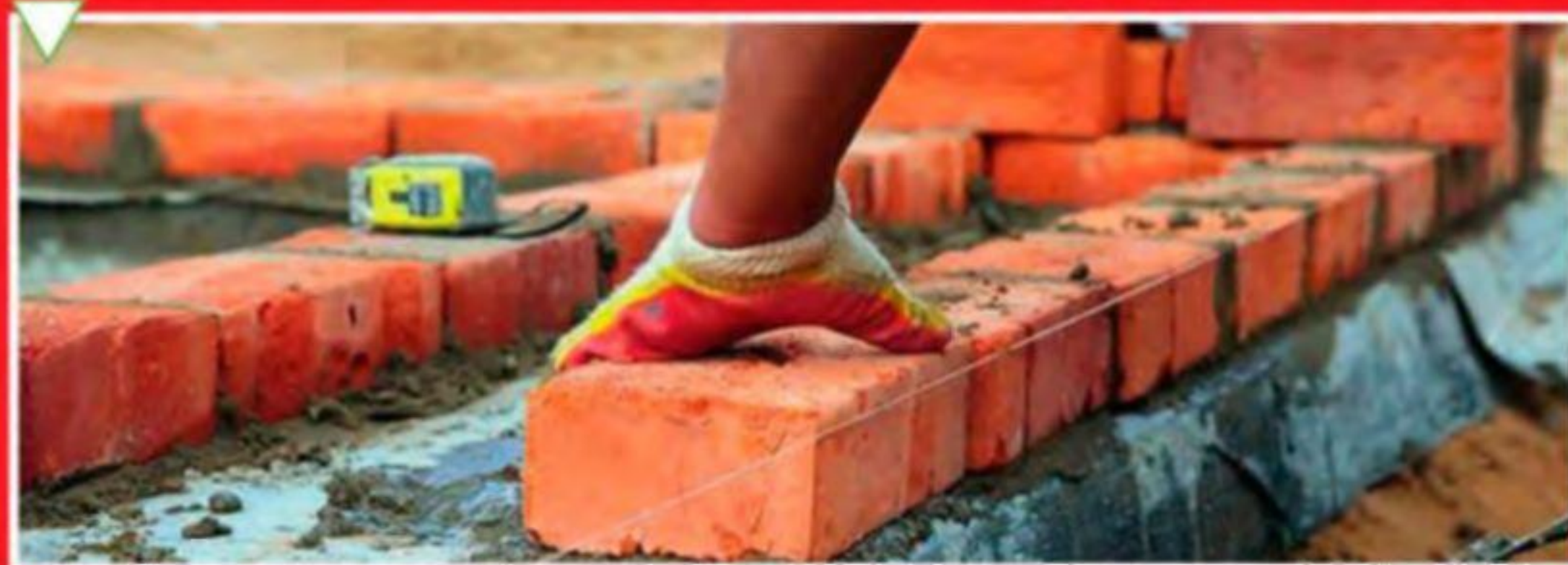
Укладка наружной и внутренней версты первого ряда кирпичной кладки уровня
