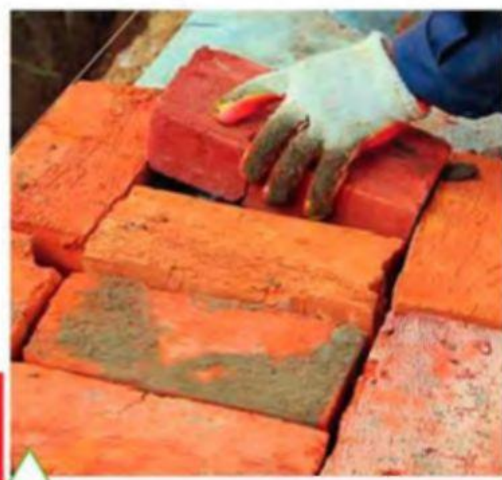
Забутка первого ряда кирпичной кладки
