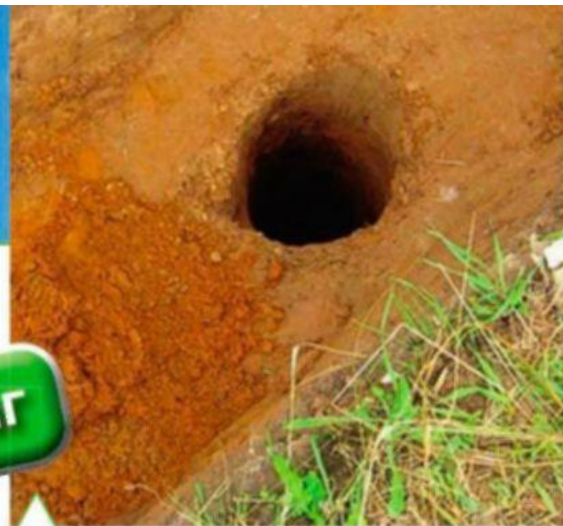
В грунте пробурили скважины под буронабивные сваи
