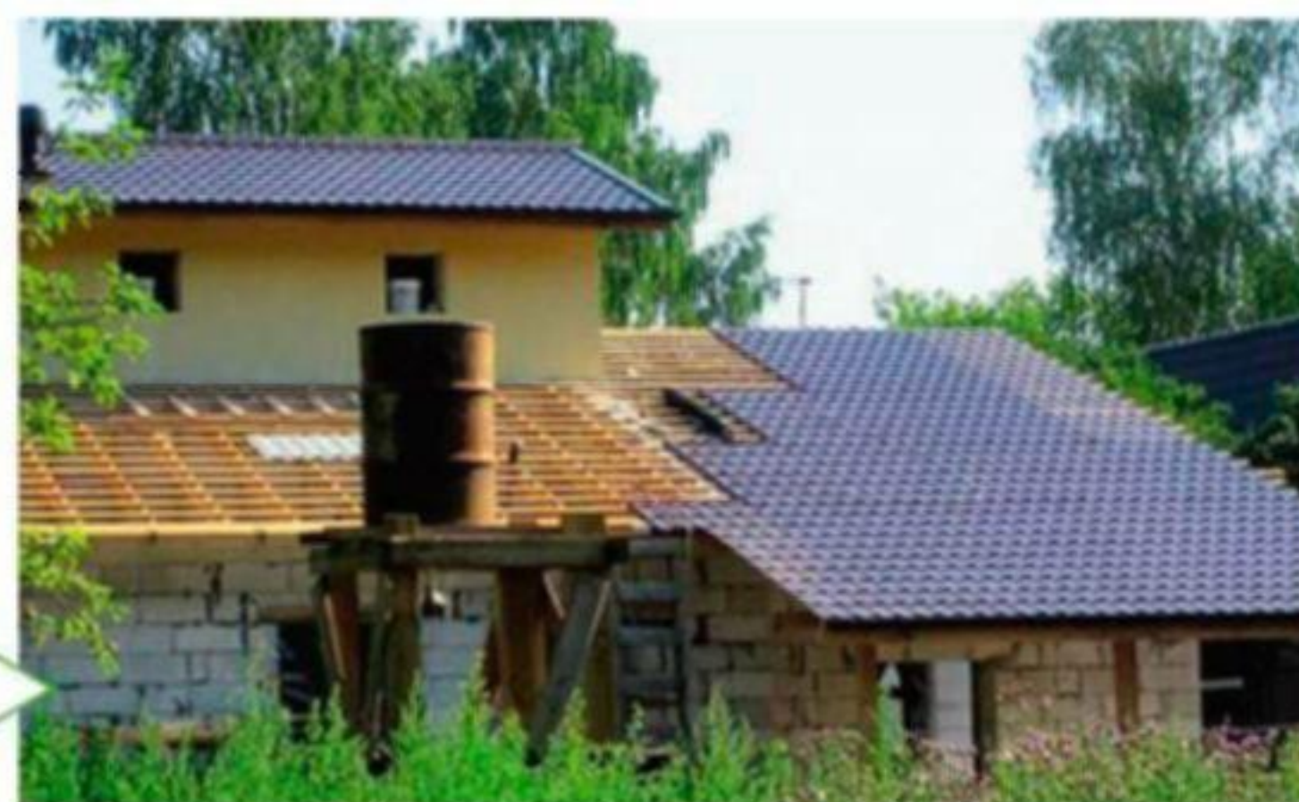
Укладка металлочерепичной кровли
