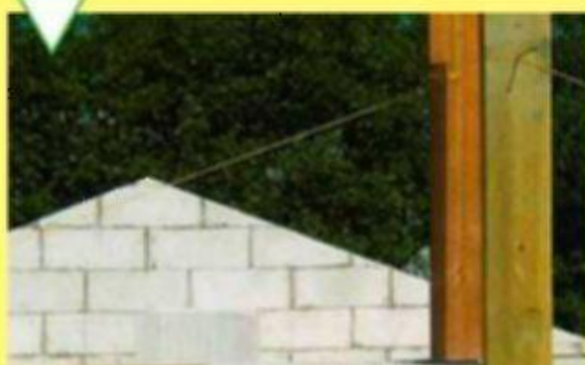
Шнур натянут для кладки треугольной стены
