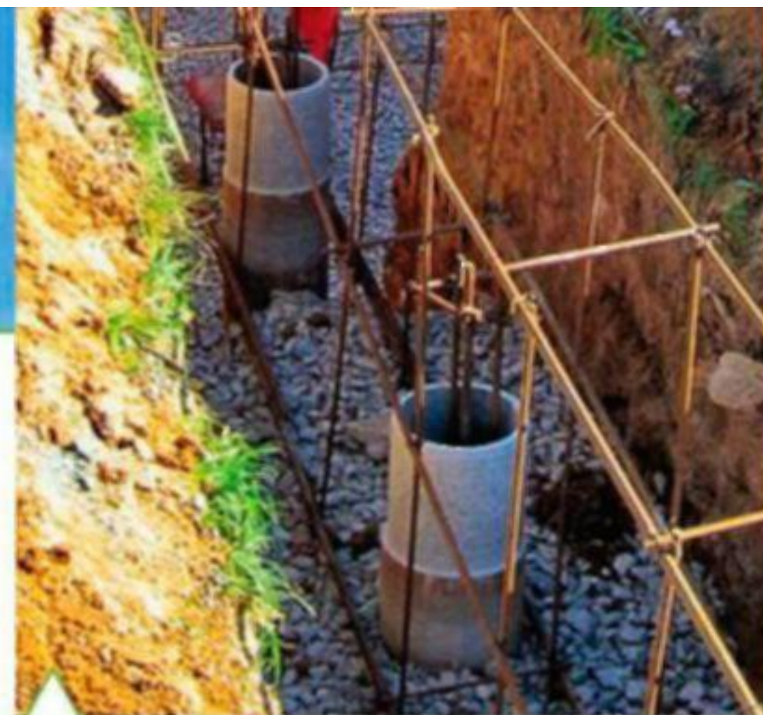
В скважины установили обсадные трубы, в которые опустили арматуру
