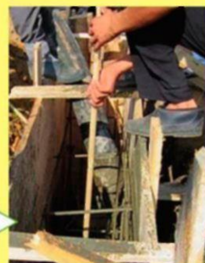
Опалубка для фундамента под криволинейный участок стены
