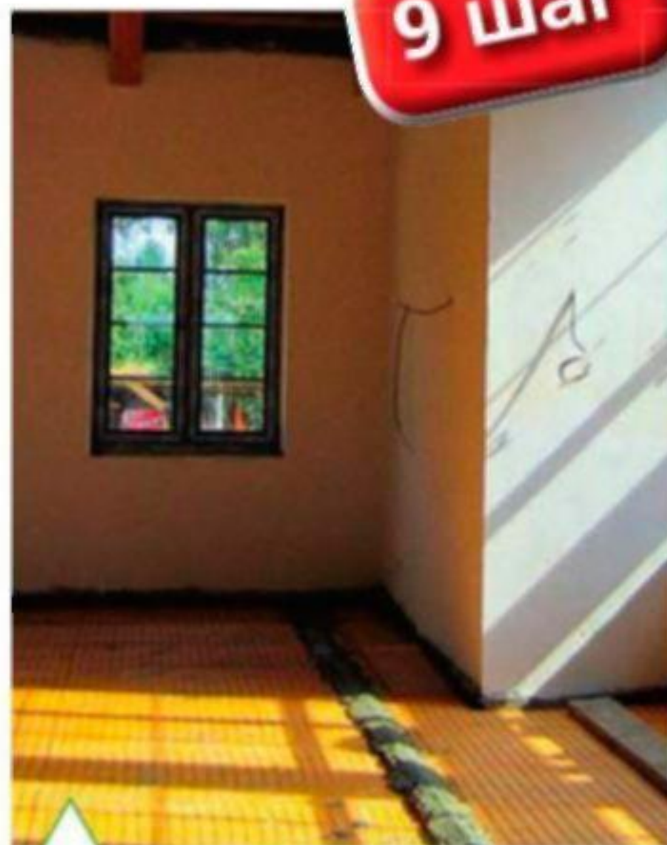
Арматурная сетка по теплоизоляционному слою из пенополистирола и маяки для создания ровной цементно-песчаной стяжки
