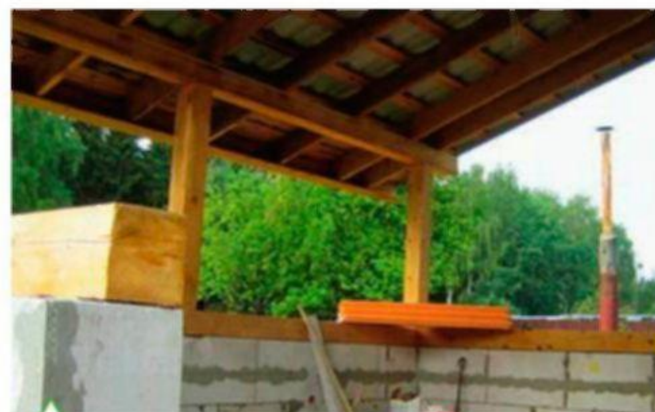
Часть крыши над будущей застекленной верандой
