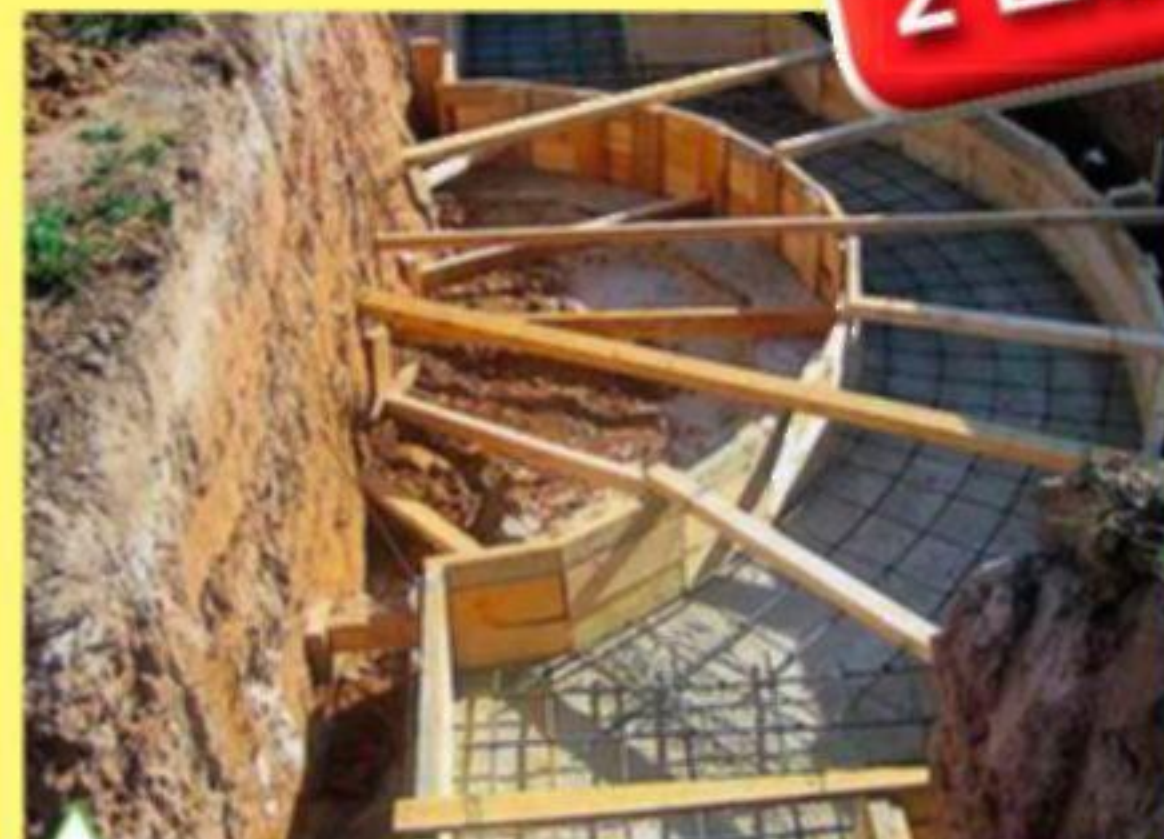
Опалубка для фундамента под криволинейный участок стены
