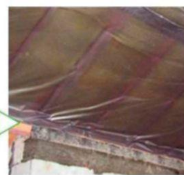
Кровельный пирог мансардной крыши
