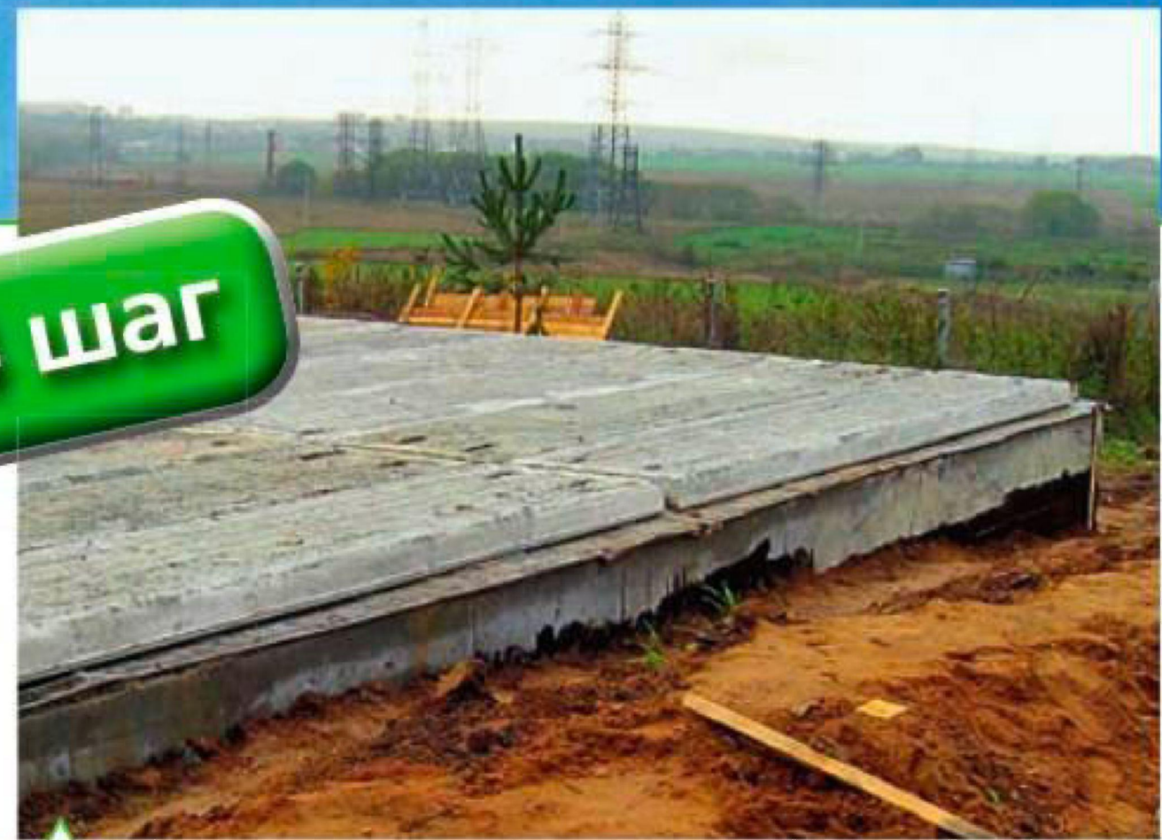
Сборное железобетонное перекрытие технического подполья
