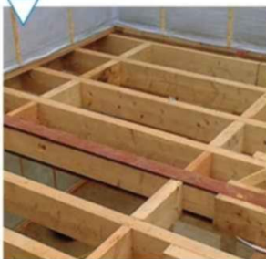
Балки перекрытия первого этажа
