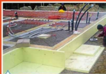
Укладка контуров водяных теплых полов и утепление фундамента
