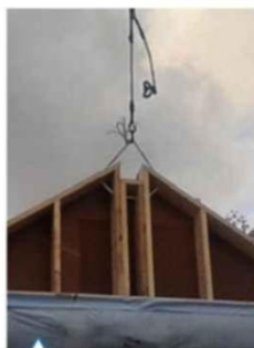
Монтаж конструкции мансардной крыши
