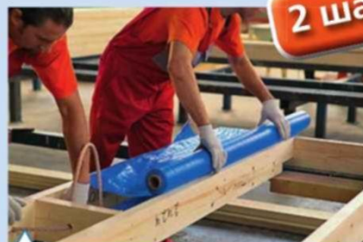
На каркас натягивают изоляционную пленку
