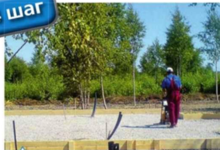
Уплотнение щебеночной подготовки перед установкой арматурного каркаса
