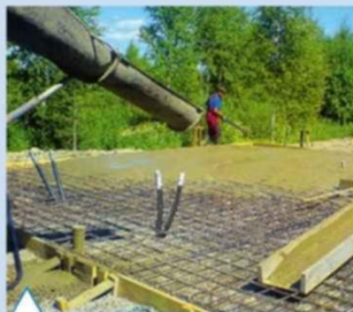
Заливка бетонной смеси
