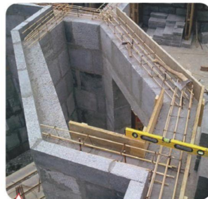
Строительство из полистиролбетона
