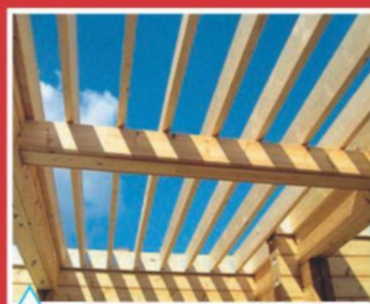
Балочное перекрытие первого этажа
