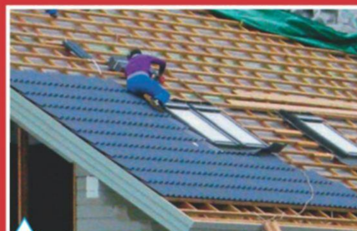
Укладка натуральной черепицы на обрешетку скатной крыши
