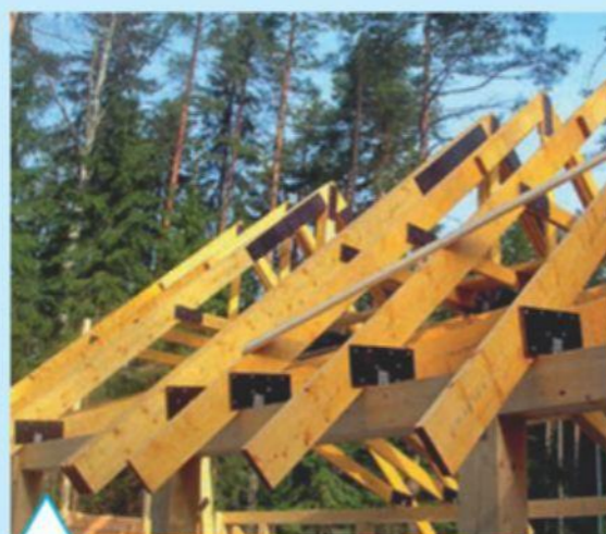
Фрагмент стропильной конструкции скатной крыши
