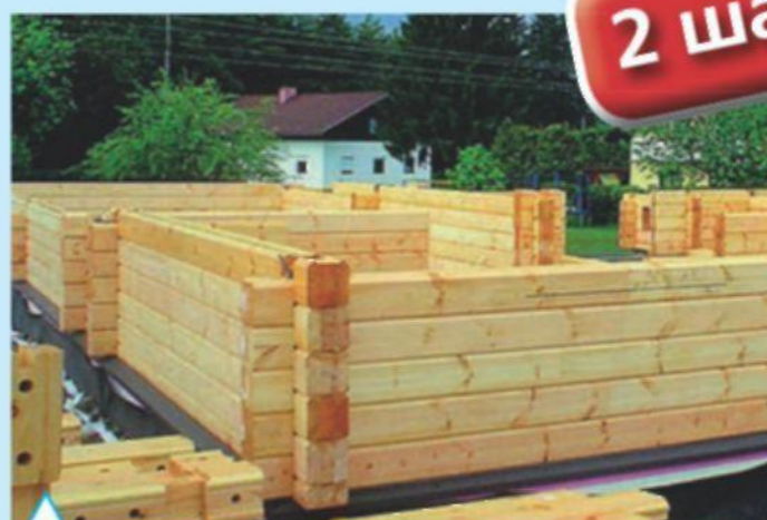
Сборка венцов первого этажа
