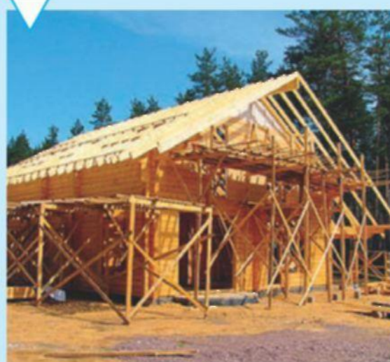
Леса установлены для выполнения фасадных работ
