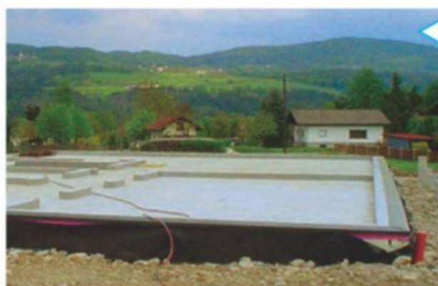
Фундамент готов к возведению стен из клееного бруса
