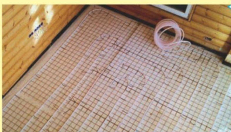
Устройство системы напольного отопления – водной теплый пол
