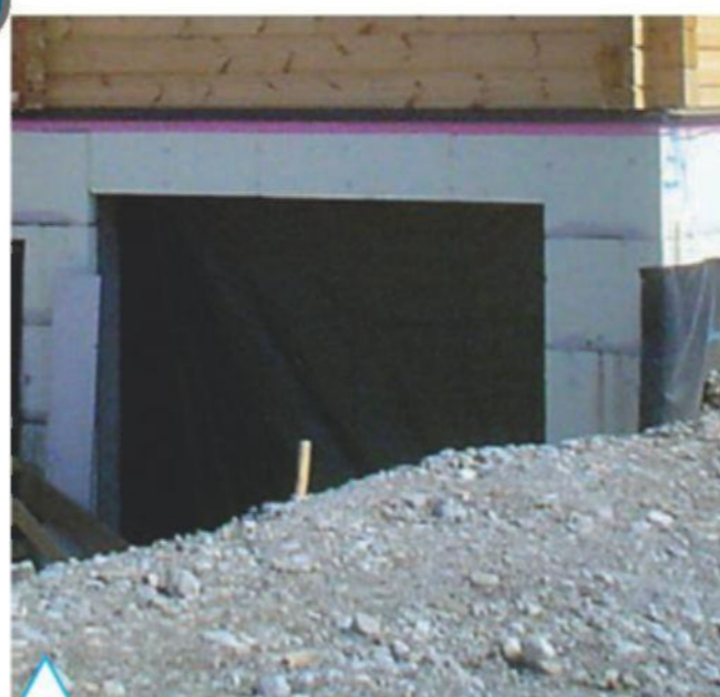
Въезд в гараж, расположенный в подвальном этаже
