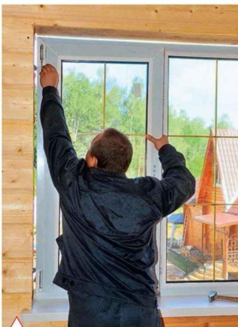
Монтаж пластикового окна Proplex в деревянном доме
