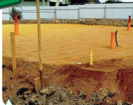
На утрамбованной песчаной подушке установлена обноска
