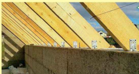
Узел крепления стропил к стенам
