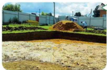
Котлован под мелкозаглубленный плитный фундамент
