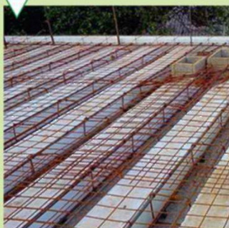
Вид перекрытия до заливки бетонной смеси
