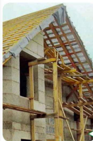
Устройство кровельного пирога
