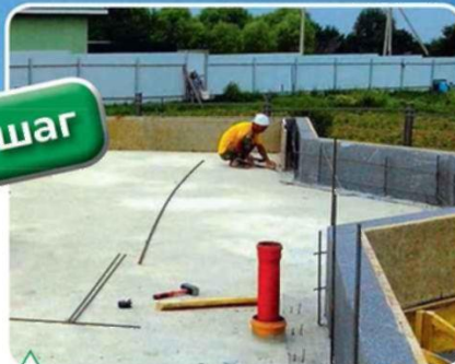
Установка несъемной опалубки из щепо-цементных плит
