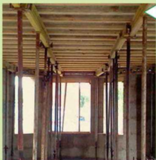
Вид перекрытия до заливки бетонной смеси
