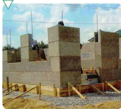
Монтаж арматурных изделий в несъемную опалубку первого этажа
