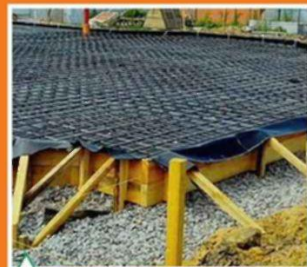
Монтаж пространственного арматурного каркаса
