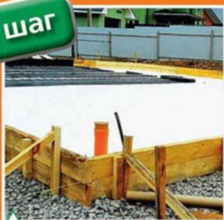
На слой экструдированного пенополистирола настилают рулонную гидроизоляцию
