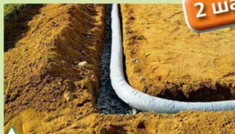
Дренажный контур вокруг фундамента
