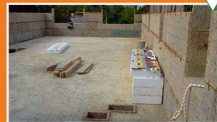
Бетонирование стен первого этажа
