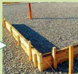
На щебеночную подготовку устанавливают деревянную опалубку
