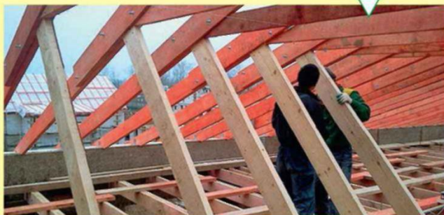
Монтаж элементов стропильной конструкции
