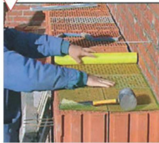
Кладка поризованных керамических блоков RAUF (завод «Победа», Россия)
