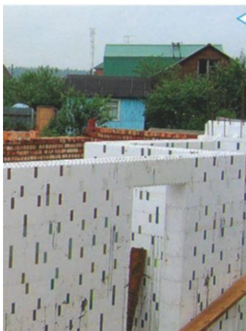
Строительство по технологии «Издол» с использованием несъемной опалубки из пенополистирола
