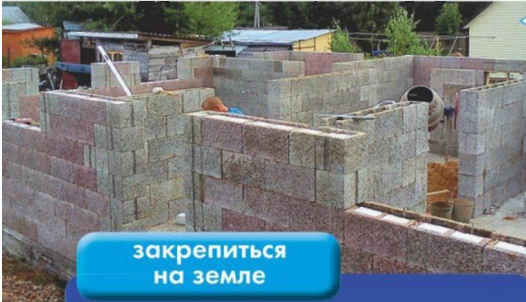
Дом построен с использованием несъемной опалубки Durisol
