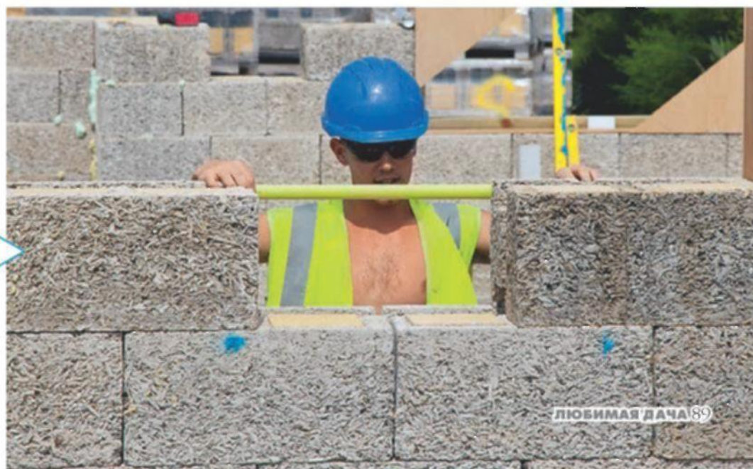
Возведение стены из щепоцементных блоков Durisol
