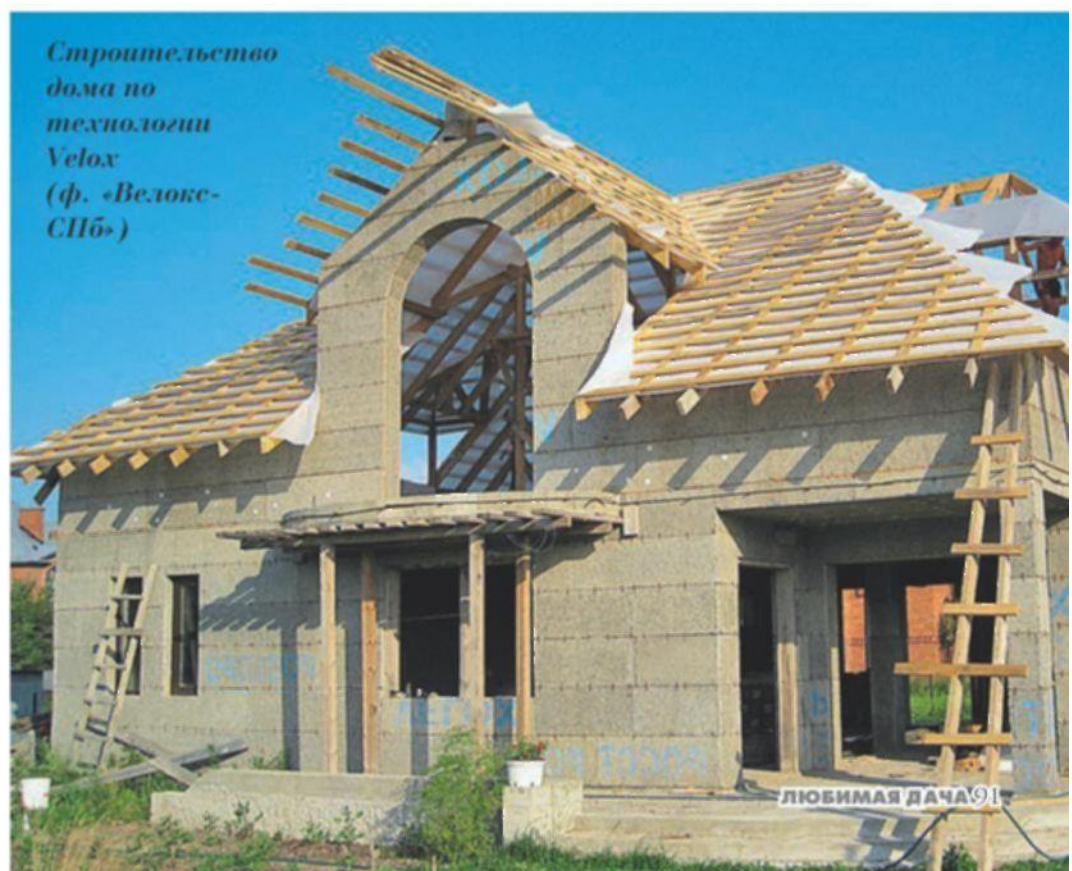
Монтаж опалубки из щепоцементных плит
