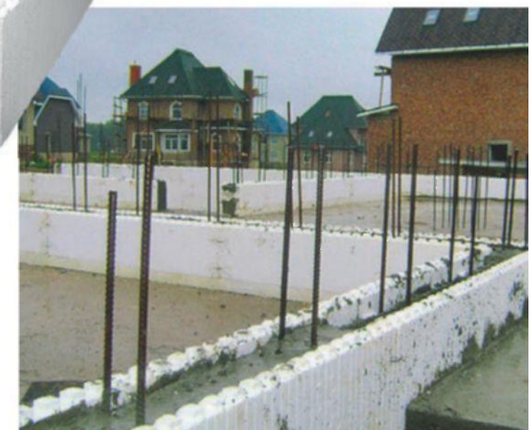
Монтаж несъемной опалубки из пенополистирола
