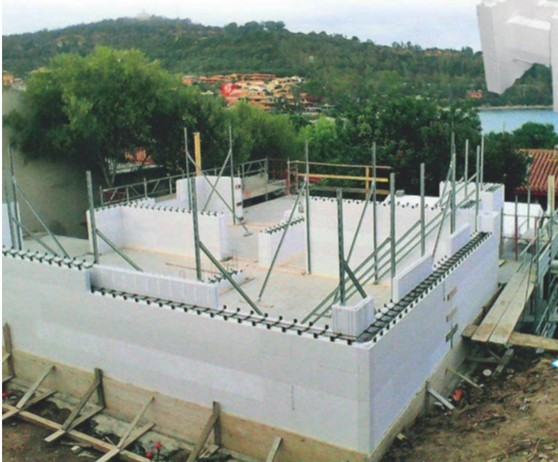
Монтаж несъемной опалубки из пенополистирола
