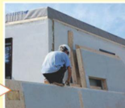
Монтаж стен первого этажа завершен
