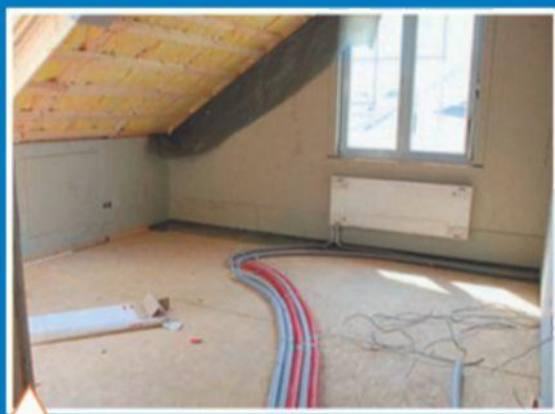
Разводка отопительной системы
