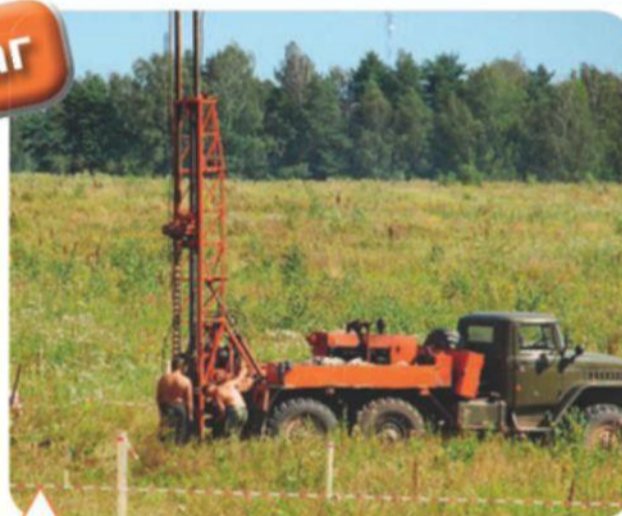
Бурение скважин под буронабивные сваи
