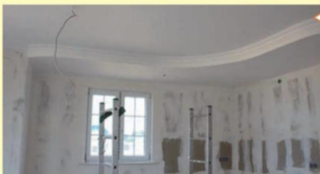
Фигурный подвесной потолок. Финишная отделка – покраска
