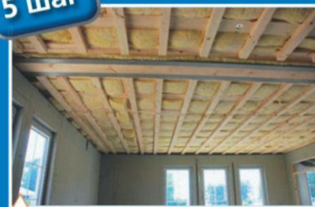
Вид междуэтажного перекрытия
