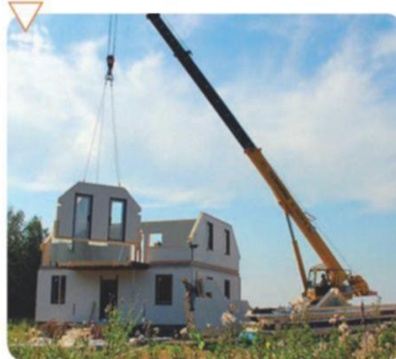
Монтаж панели главного фасада с установленными балконными блоками
