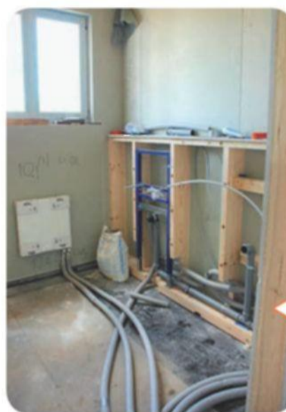
Инсталляционная система для монтажа сантехнического подвешенного оборудования
