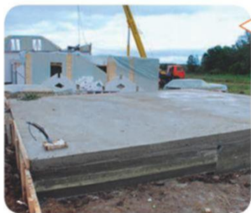
Вид готового фундамента
