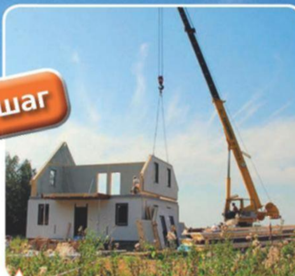
Монтаж фронтона мансарды
