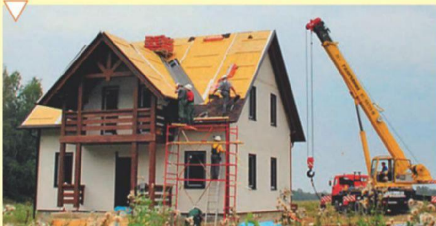
Укладка битумной черепицы
