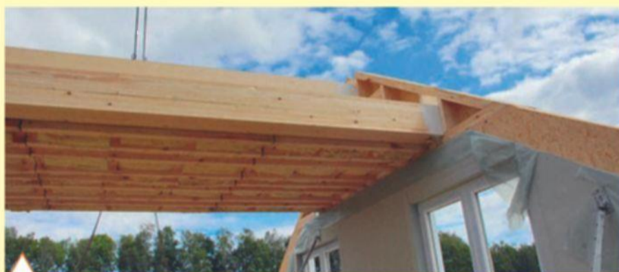
Монтаж элементов стропильной конструкции
