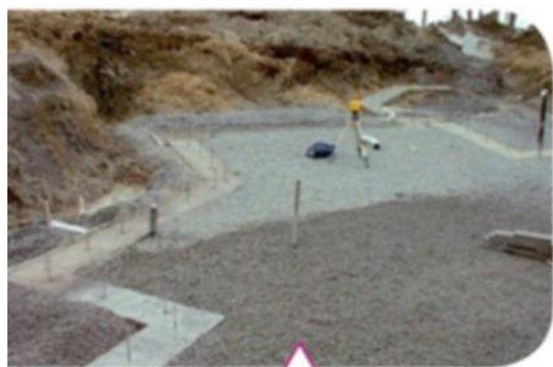
Устройство монолитного футинга
