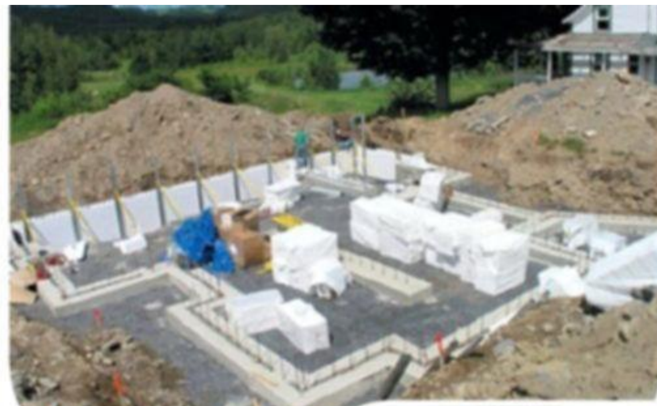
Возведение стен цокольной части дома
