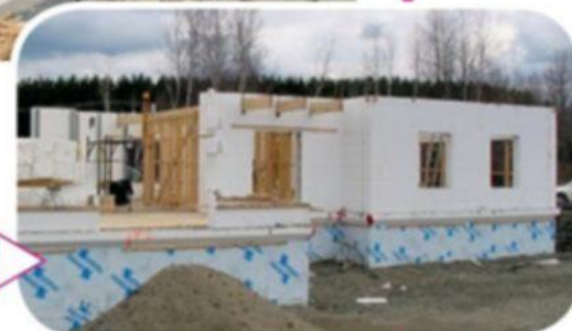
Возведение стен цокольной части дома
