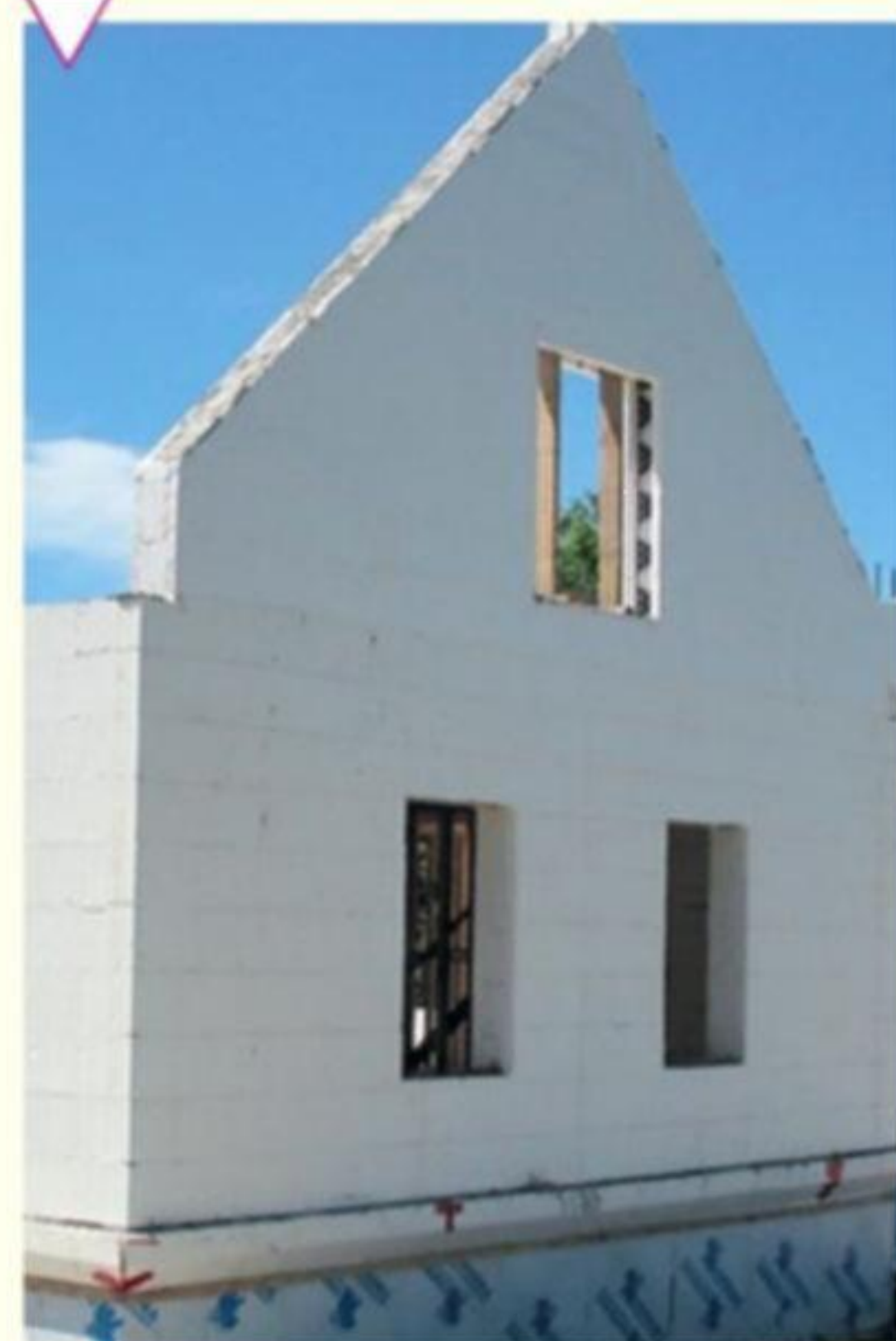
Фронтоны мансардной крыши, собранные из пенополистирольных блоков
