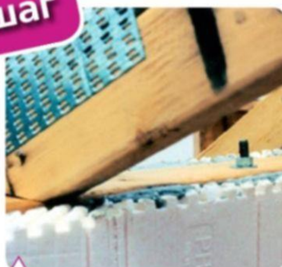
Узел опирания стропил на стены
