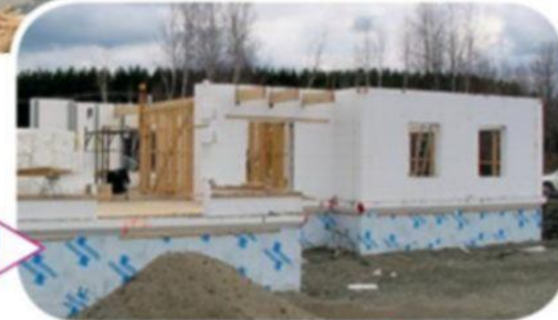
Возведение стен цокольной части дома
