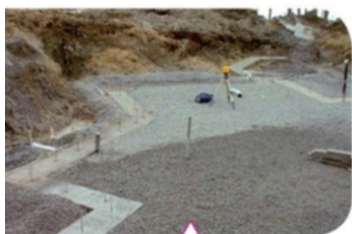
Устройство монолитного футинга
