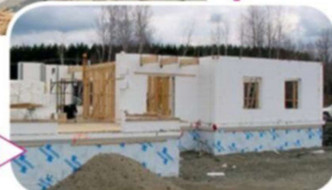
Возведение стен цокольной части дома
