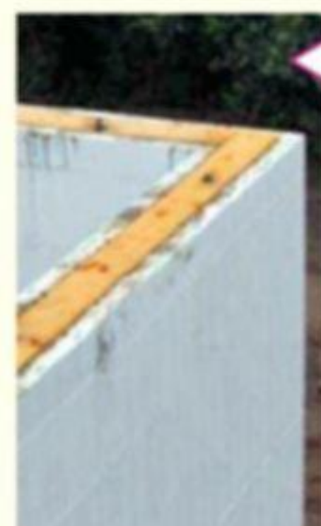
Зафиксированный в стене деревянный брус (мауэрлат) для крепления стропил скатной крыши
