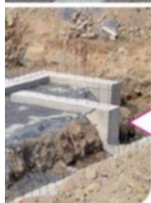
Устройство монолитного футинга
