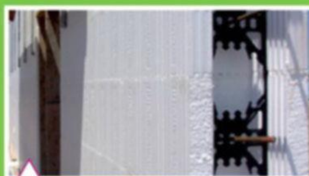
Вид торца фрагмента стены из несъемной полистирольной опалубки
