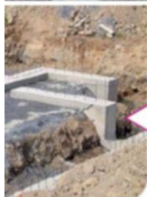
Возведение монолитной ленты под стены из пенополистирольных блоков
