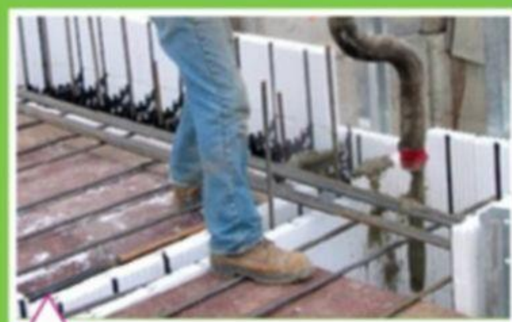
Заливка бетонной смеси в несъемную опалубку из пенополистирольных блоков
