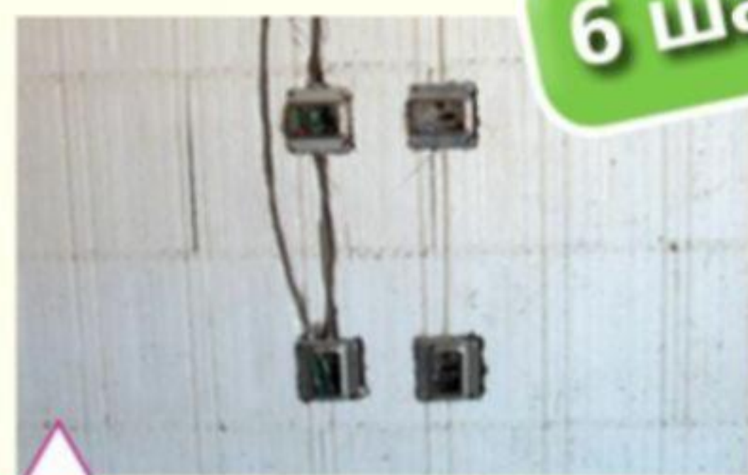
Прокладка электропроводки в стенах скрытым способом
