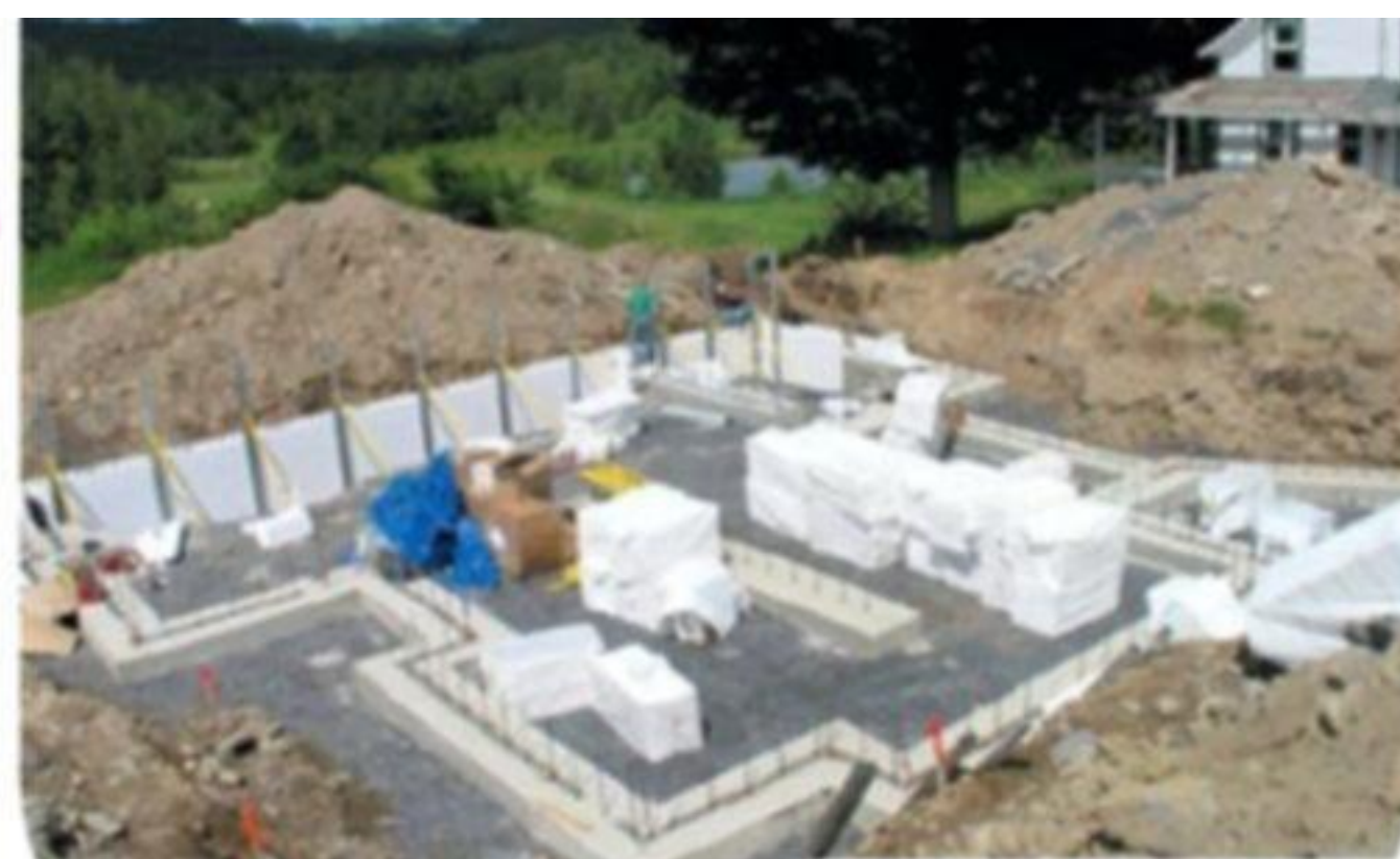
Возведение стен цокольной части дома
