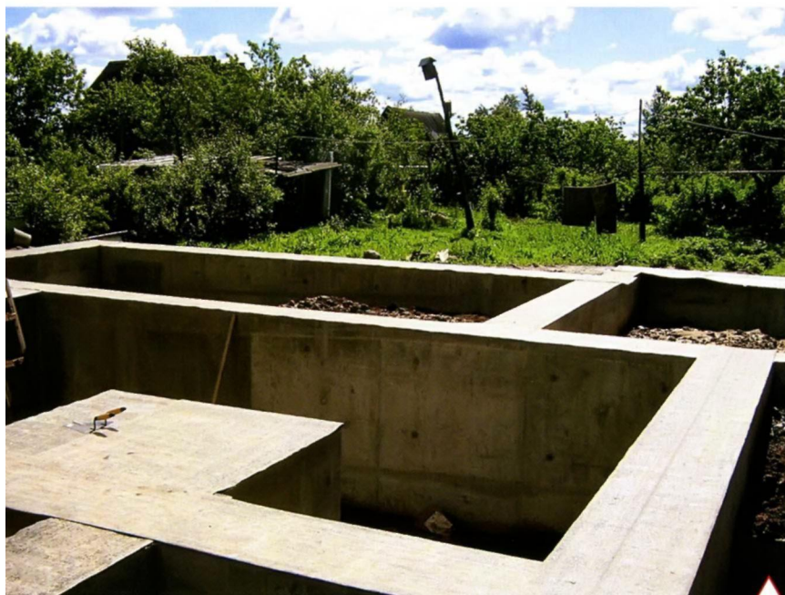
Монолитный железобетонный ленточный фундамент заложен на глубину промерзания грунта
