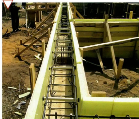
Свайный фундамент. Поверху сваи связаны воедино железобетонной лентой-ростверка
