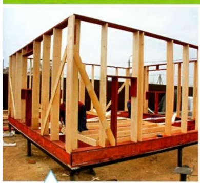
Монтаж каркаса стен первого этажа
