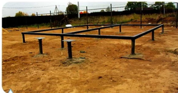
Фундамент на винтовых сваях
