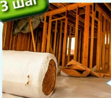
Утепление стен минераловатными матами
