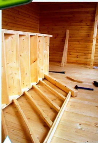
Монтаж внутренней деревянной лестницы
