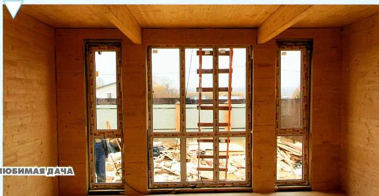
Обшивка стен вагонкой
