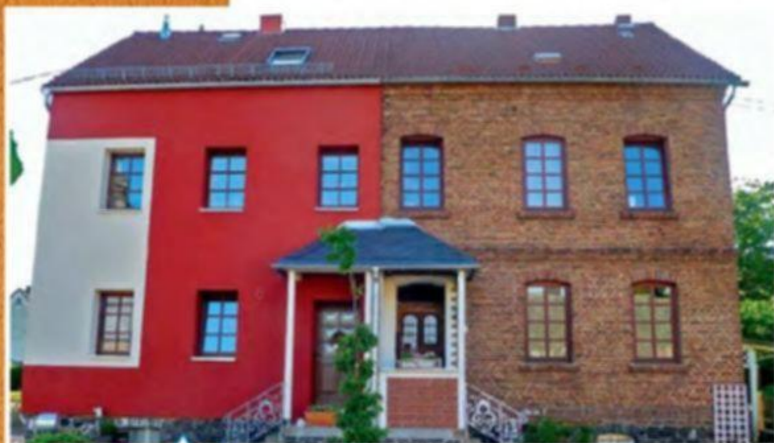
Обновление фасада старого дома с помощью декоративной штукатурки
