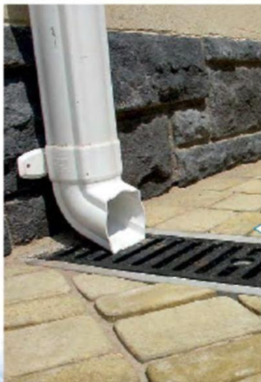
Под водостоком устроен дождеприемник
