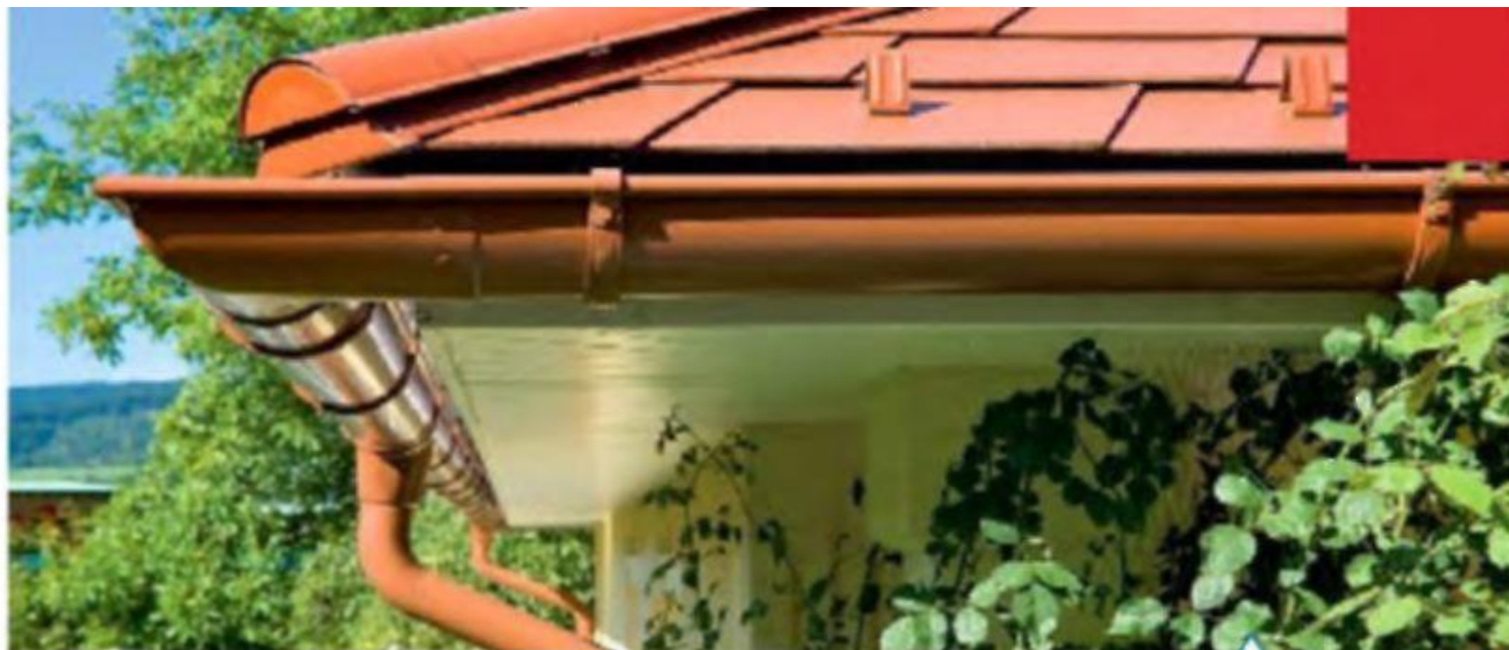
Алюминиевая водосточная система Prefa (Германия)
