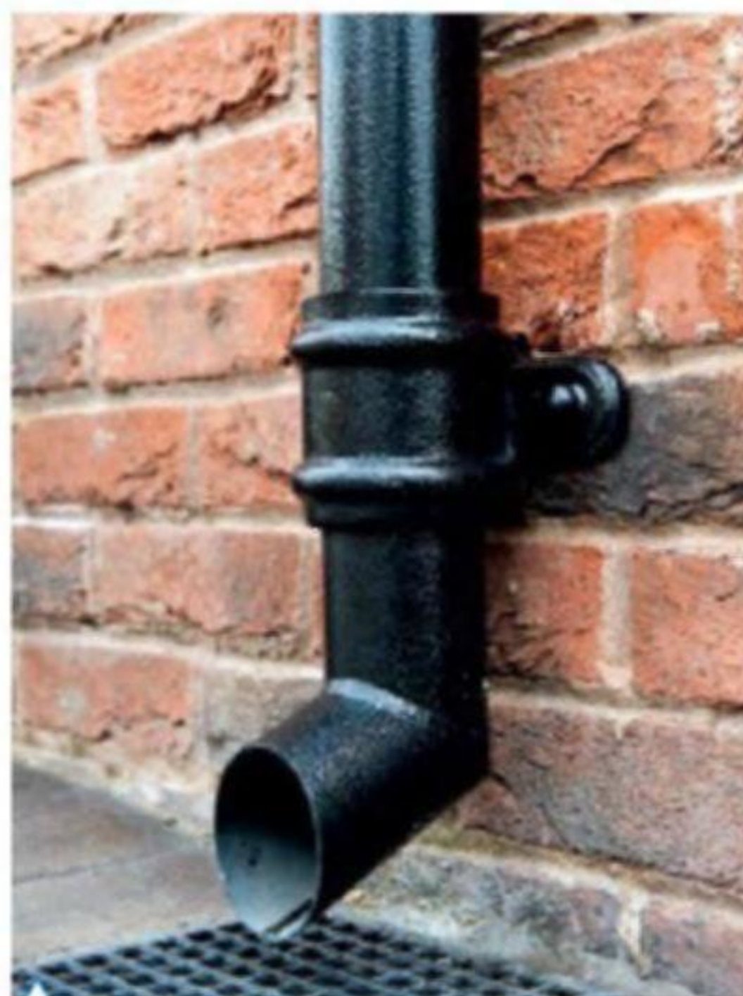
Под водостоком устроен дождеприемник
