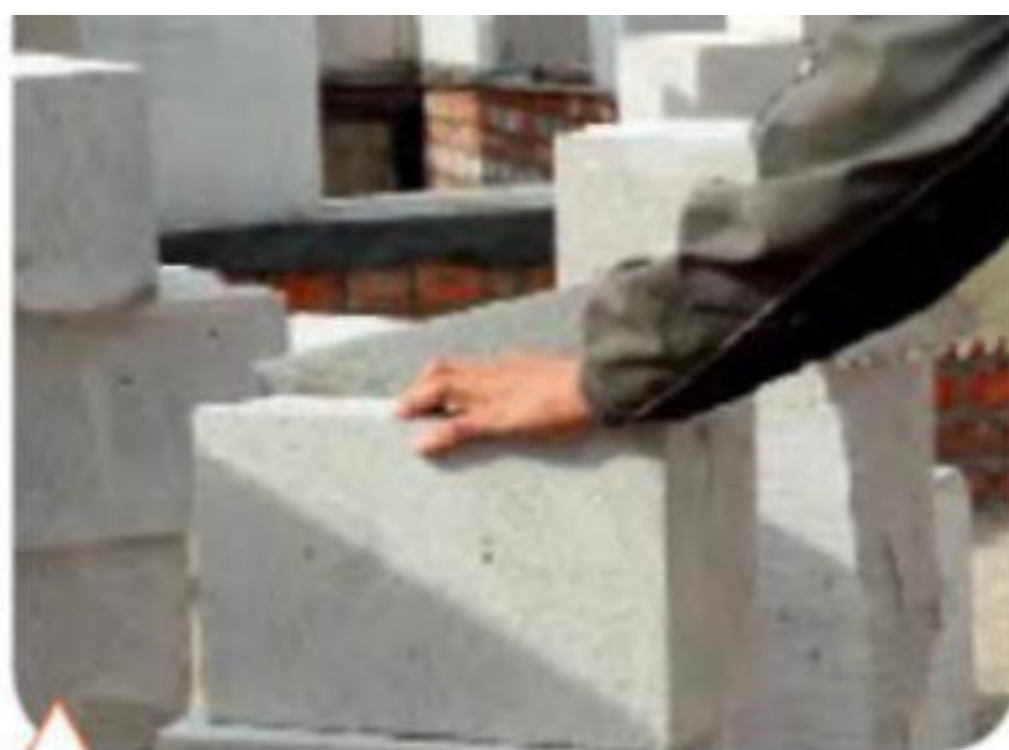
Газобетонный блок зачищают обычной ножовкой
