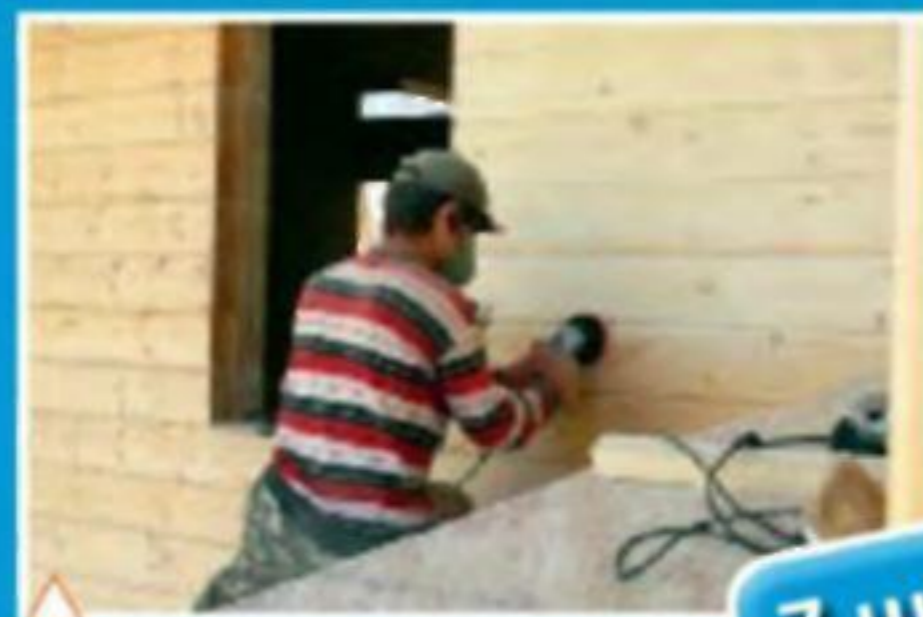
Стены из клееного бруса шлифуют с помощью насадки на электродрель
