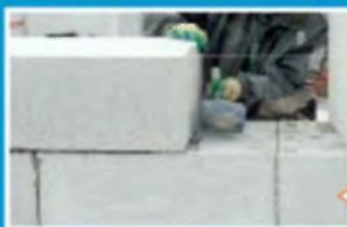
Специальным ковшем аккуратно наносят слой минерального клея
