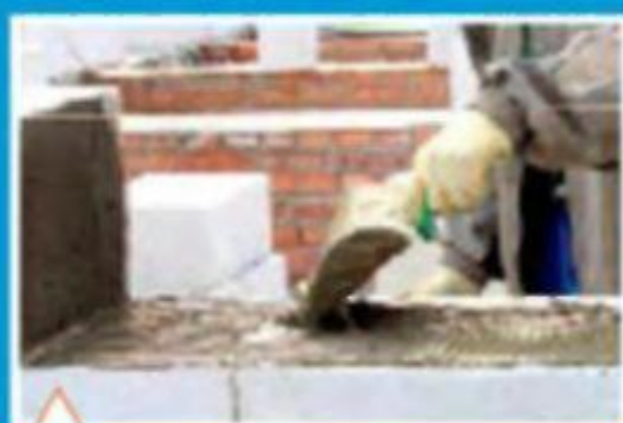
Специальным ковшем аккуратно наносят слой минерального клея
