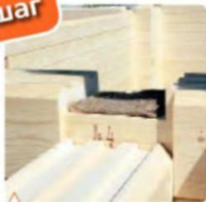
Вид углового соединения с межвенцовым уплотнителем
