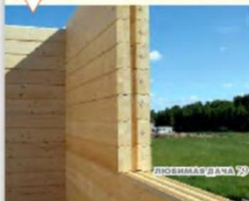
Вид собранной стены со стороны оконного проема
