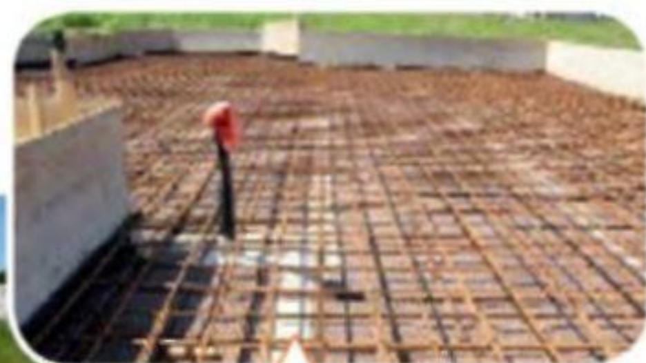
Арматурный каркас смонтирован на дренажном полотне
