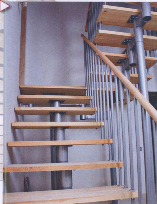
Лестница на стальном косоуре кольчатой конфигурации (ф. «Изма-лестница»)
