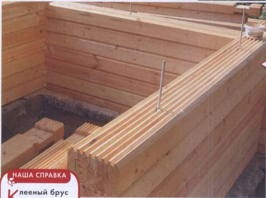
Клееный брус Good Wood с «фирменным» профилем, обеспечивающим плотное соединение венцов
