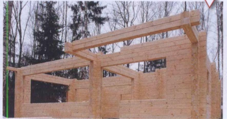
Строительство дома из утепленного бруса (ф. «Малер Хаус»)
