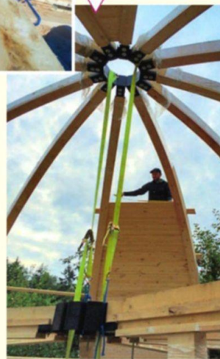
Формирование зенитного узла. Начало обшивки каркаса
