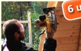
Обрезка внутренней обшивки по периметру оконного проема
