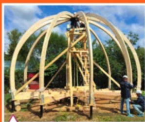
Фиксация дугообразных сегментов в зените полусферы
