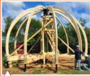
Фиксация дугообразных сегментов в зените полусферы
