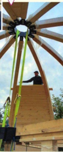
Формирование зенитного узла. Начало обшивки каркаса
