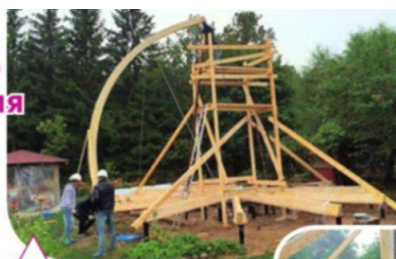
Монтаж криволинейных сегментов, формирующих сферический каркас
