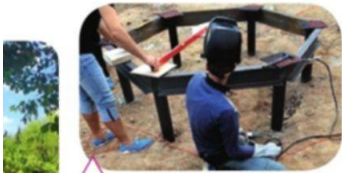
Выверяют горизонтальное положение металлического ростверга внутреннего шестиугольника
