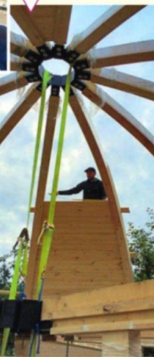
Формирование зенитного узла. Начало обшивки каркаса
