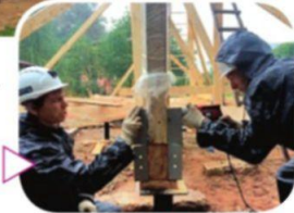
Монтаж криволинейных сегментов, формирующих сферический каркас
