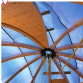
Монтаж паро-, гидроизоляционной мембраны
