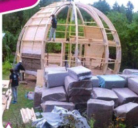
Монтаж экологического утеплителя
