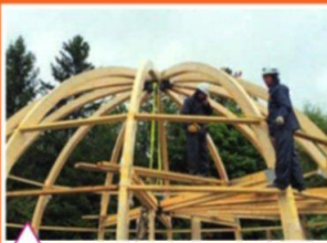
Монтаж распорных балок
