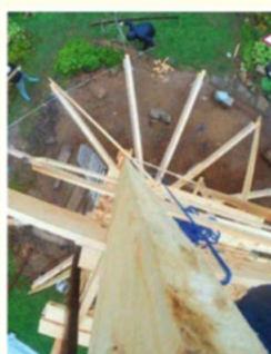
Вид несущих элементов каркаса сверху
