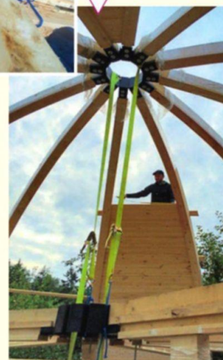
Формирование зенитного узла. Начало обшивки каркаса
