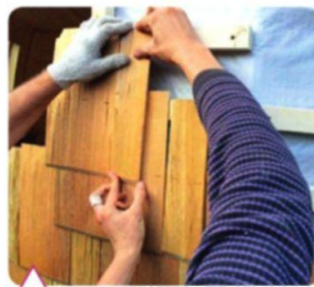
Крепление деревянных пластин фасадной отделки
