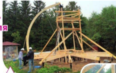
Монтаж криволинейных сегментов, формирующих сферический каркас
