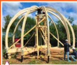
Фиксация дугообразных сегментов в зените полусферы
