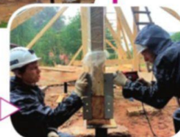
Монтаж криволинейных сегментов, формирующих сферический каркас
