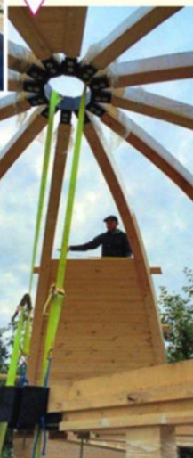
Формирование зенитного узла. Начало обшивки каркаса
