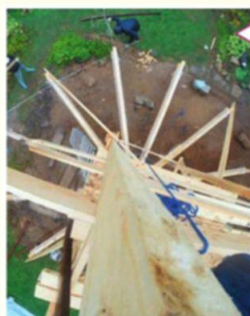
Вид несущих элементов каркаса сверху
