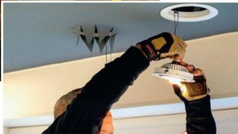
Монтаж светильников в натяжной потолок Сірсо
