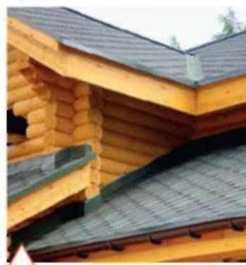
Кровельное покрытие из битумной черепицы
