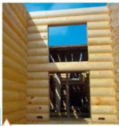
Вид внутренней стены с дверным проемом в процессе сборки сруба
