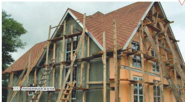
Возведен каркас дома из стальных термопрофилей
