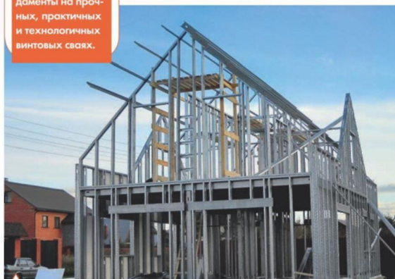
Возведен каркас дома из стальных термопрофилей
