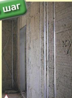
Утепление каркасных стен
