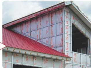
Металлочерепичное покрытие скатной крыши
