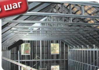
Вид каркаса мансардного этажа
