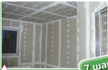
Внутренняя обшивка стен гипсокартонными листами
