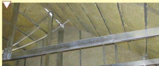
Утепление скатной крыши
