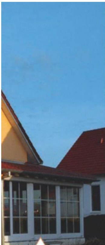
▲ Фасад после утепления «по мокрому типу»
