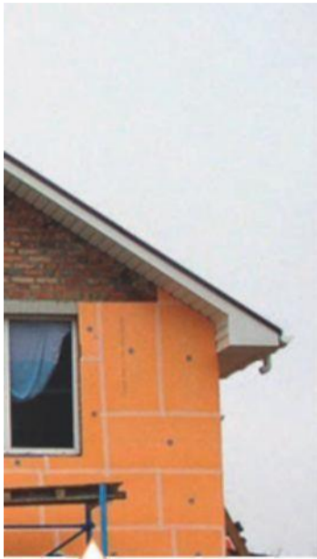
Утепление фасада плитами «ПЕНОПЛЭКС» из экструдированного пенополистирола
