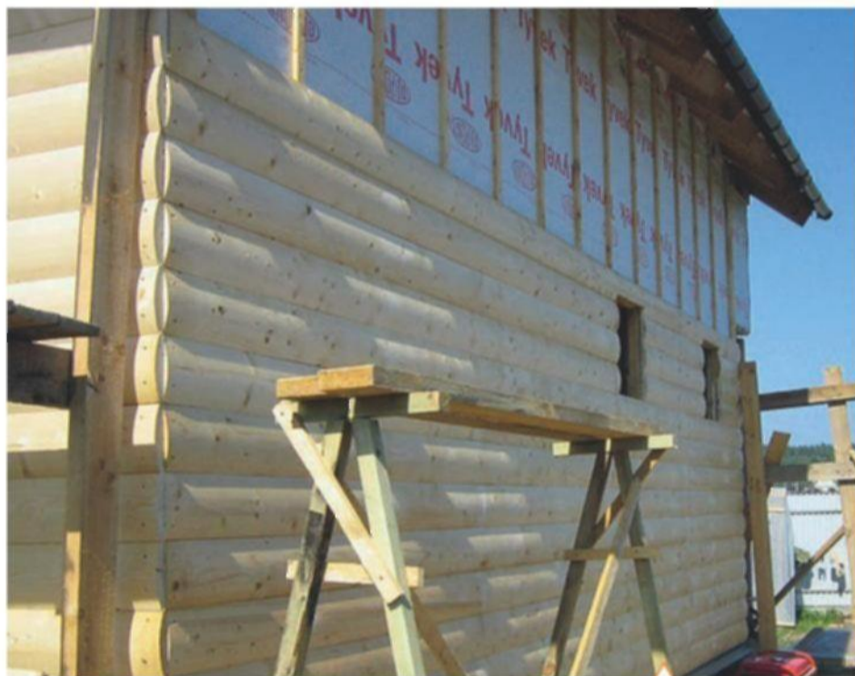
▲ Утепление фасада по вентилируемому типу
