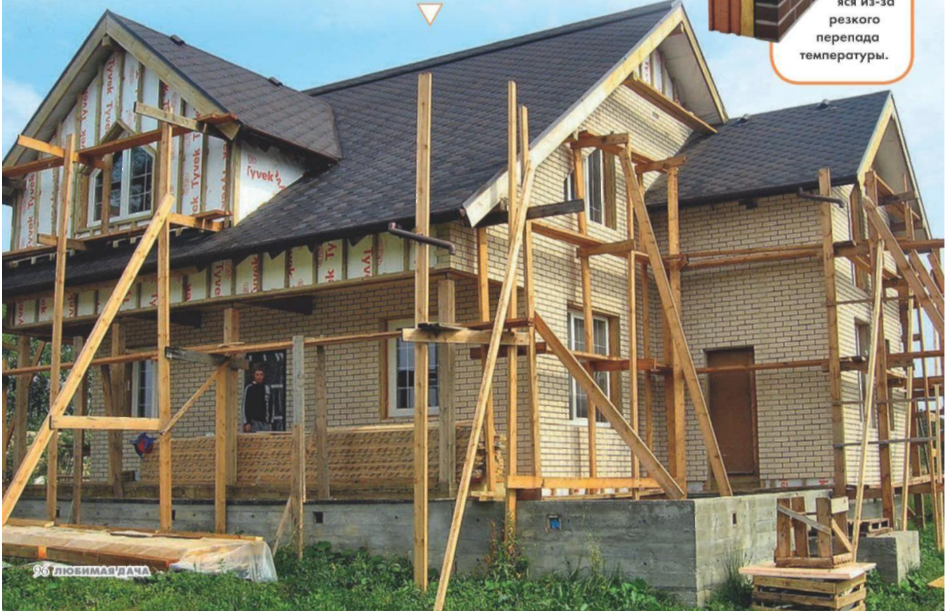
Устройство вентилируемого фасада с облицовкой плиткой
