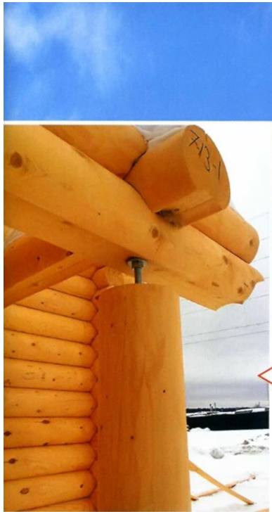
Установка вертикальной опоры на винтовом домкрате (ф. «Гарант-Строй»)
