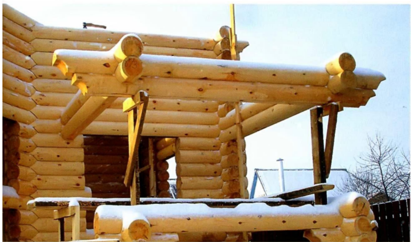
Установка вертикальной опоры на винтовом домкрате (ф. «Гарант-Строй»)
