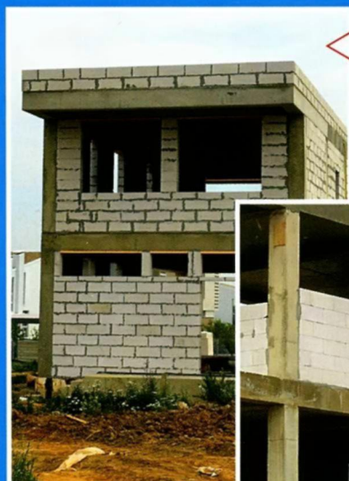
Возведение самонесущих блочных стен завершено
