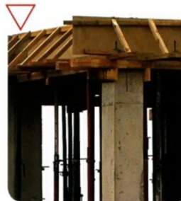
Бетонирование монолитной плиты покрытия
