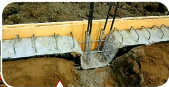
Узел стыковки армирования стойки каркаса с фундаментом
