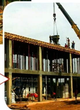
Бетонирование перекрытия дома (перекрытия второго этажа)
