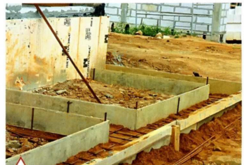
Сооружение наружной лестницы у главного фасада
