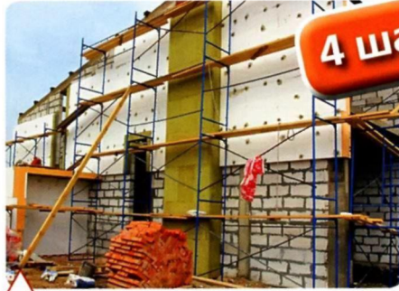
Монтаж фасадного утепления
