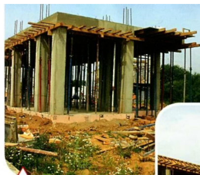
Железобетонный каркас первого этажа
