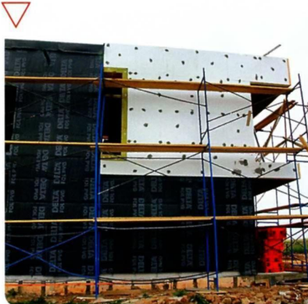
Монтаж гидроветрозащитной мембраны
