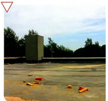
Вид плоской крыши
