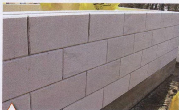
Стена из газобетонных блоков (ф. «ХоумСтрой»)
