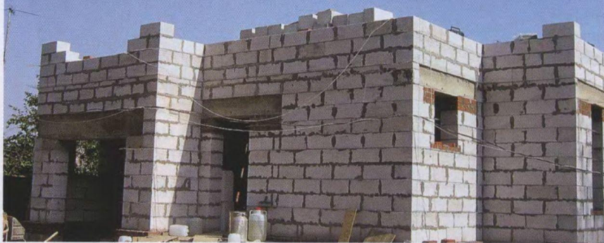
Строительство коттеджа из газобетонных блоков Hebel (ООО «Загородный дом»)
