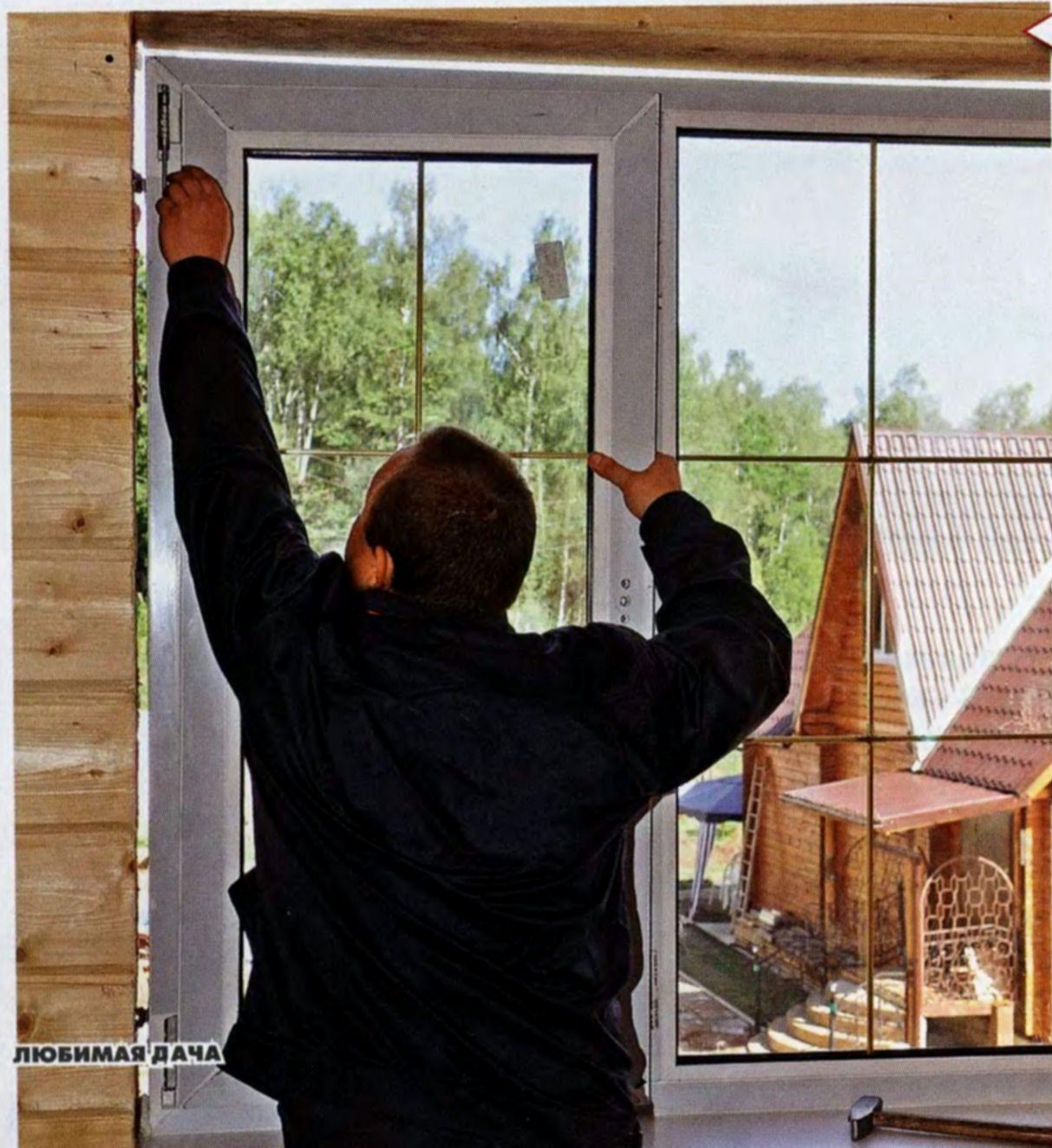
Установка окон на основе профильной системы Proplex
