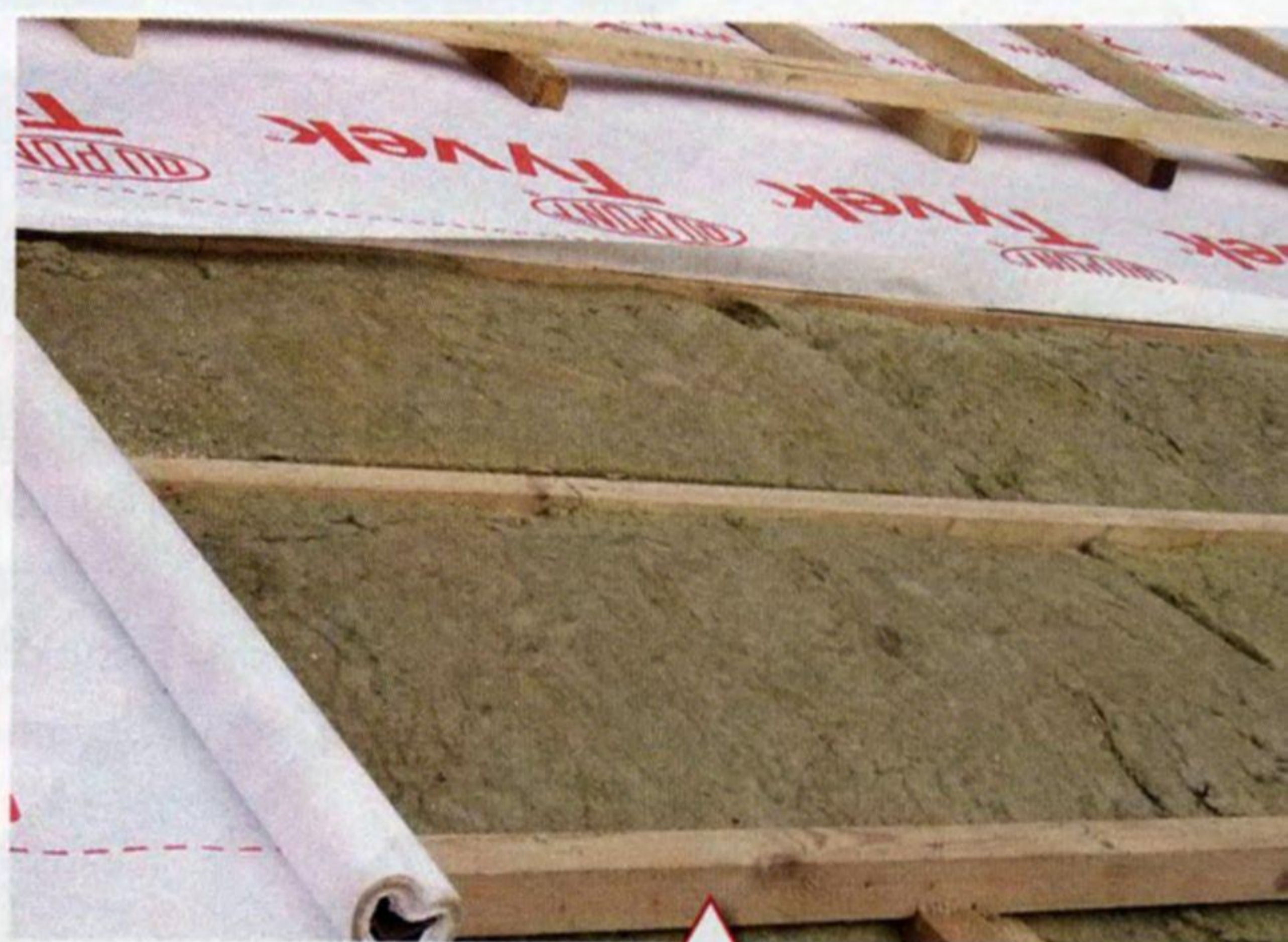
Утепленная скатная стена мансарды готова к отделке деревянной вагонкой
