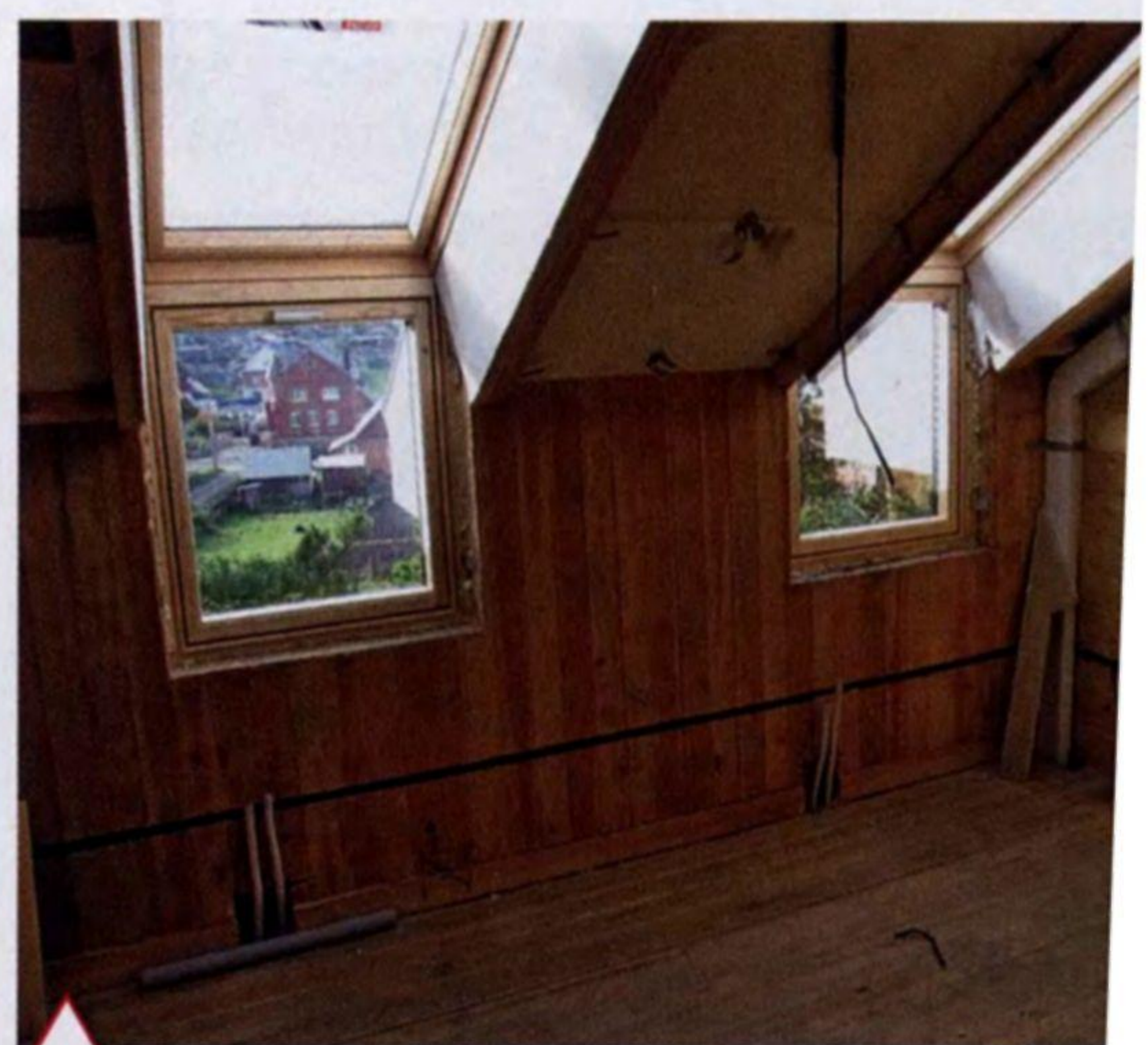
Мансарда перед началом внутренней отделки. Установлены окна Velux
