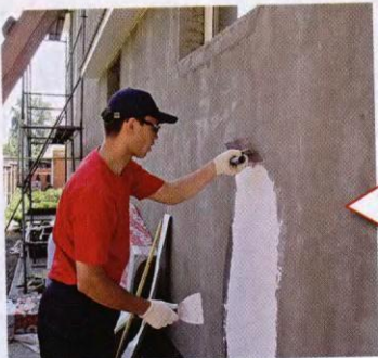
Процесс монтажа пенополистирольных утеплителей
