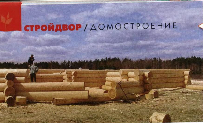
Предварительная сборка сруба на производственной площадке (ф. «ВладимирСтройЛес»)
