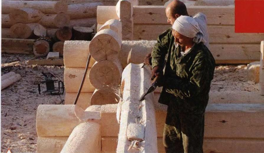
▲ Сборка сруба на строительной площадке (ф. «Владимир-Строй.Тес»)
