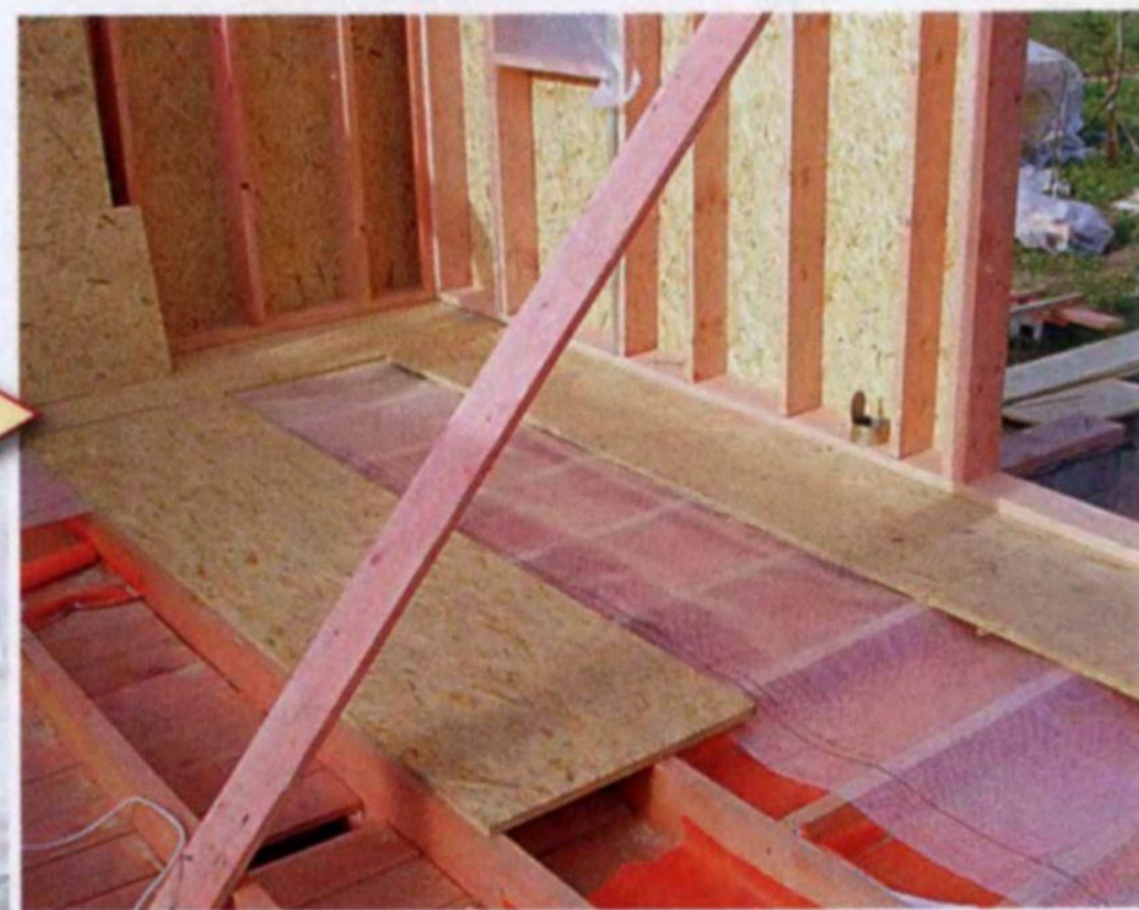
Тепло- и пароизоляция каркасного дома (ф. «Стройдром»)
