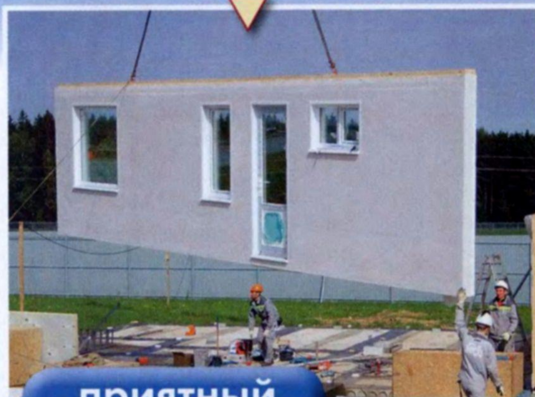
Монтаж панелей полной заводской готовности (ф. MOZAIK Development)
