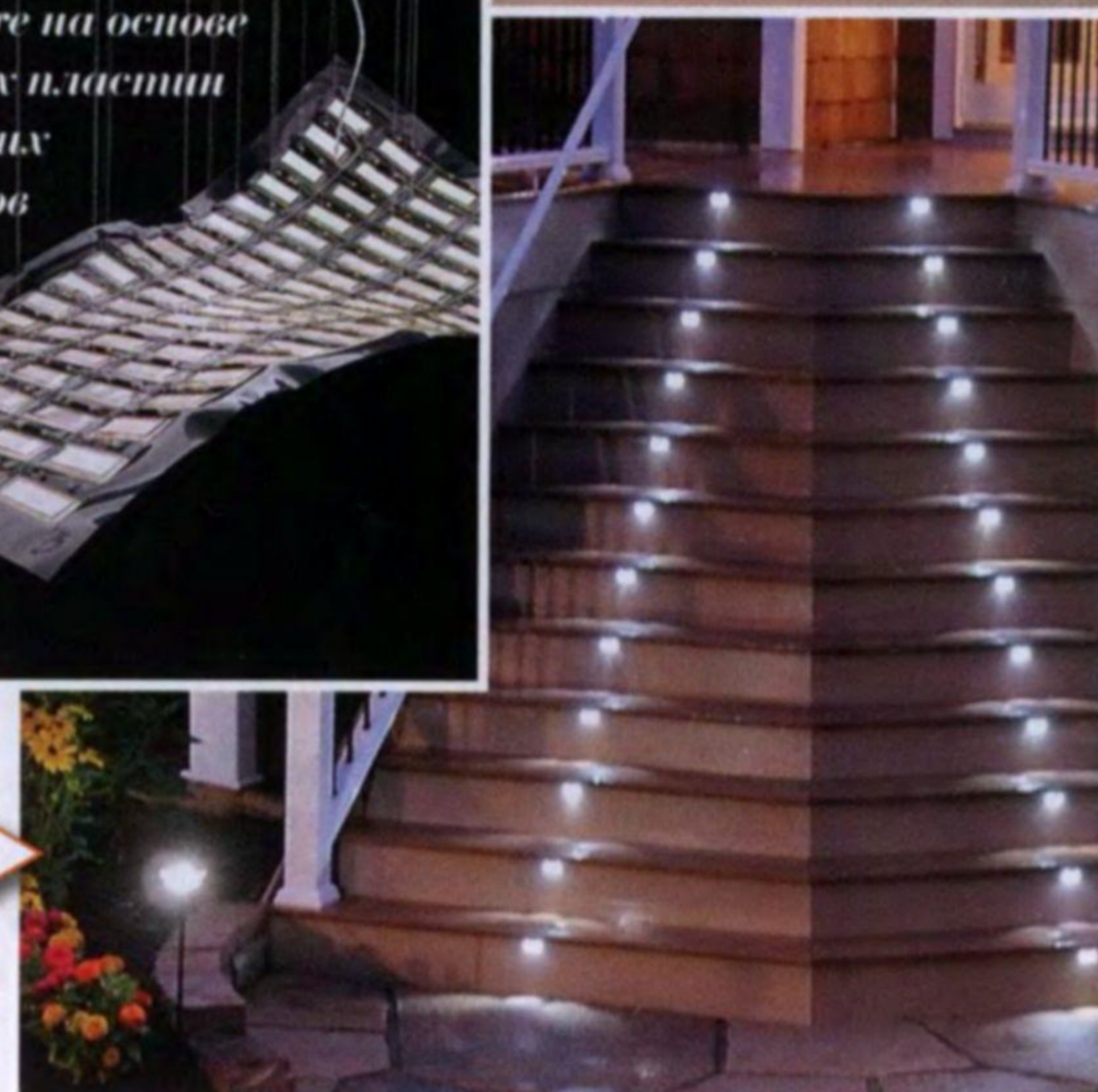
В ступени лестницы встроены светодиодные лампы
