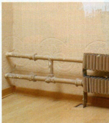
▲ Подключение старого и нового радиаторов
