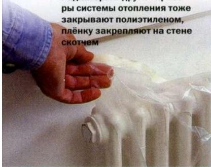
**Радиаторы и другие приборы системы отопления тоже закрывают полиэтиленом, пленку закрепляют на стене скотчем**
