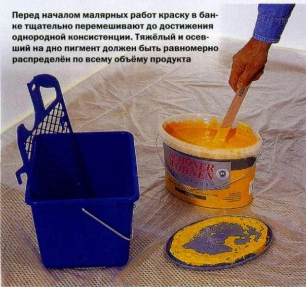
Перед началом малярных работ краску в банке тщательно перемешивают до достижения однородной консистенции. Тяжёлый и осевший на дно пигмент должен быть равномерно распределён по всему объёму продукта
