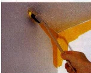
◀ Сначала закрашивают области по периметру стены и углы. Для этого используют плоскую кисть. Упростит работу инструмент с изогнутой ручкой. Такая кисть поможет закрасить и труднодоступные места за радиатором
