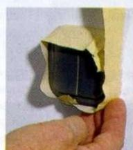
► Напольное покрытие застилают защитной пленкой, которую фиксируют с помощью самоклеящейся ленты (малярного скотча). Рулоны раскатывают внахлест, стыки также проклеивают малярным скотчем
