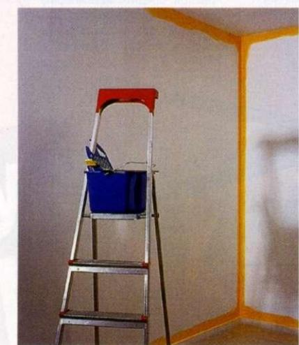
◀ Сначала рекомендуется загрунтовать стены. Затем обрабатывают контуры стен (внутренние углы, а также полосы у плинтуса и потолка). Внутренние поля подготовлены к нанесению краски валиком. При выполнении малярных работ потребуется стремянка
