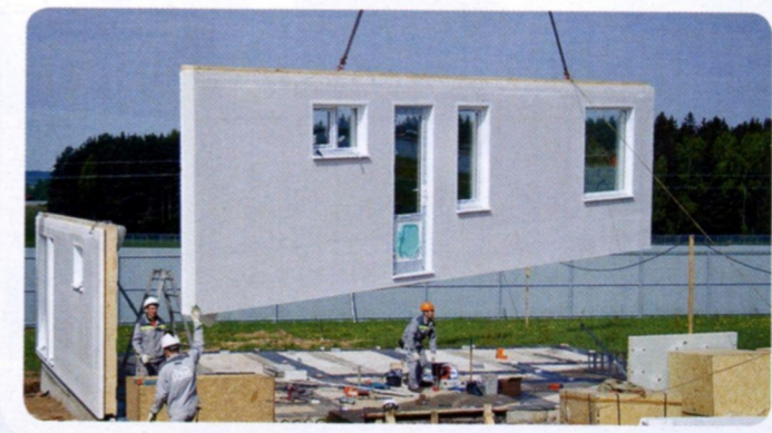
Строительство дома по немецкой каркасно-панельной технологии (ф. Mozaik)
