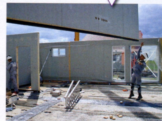
Строительство дома по немецкой каркасно-панельной технологии (ф. Mozaik)
