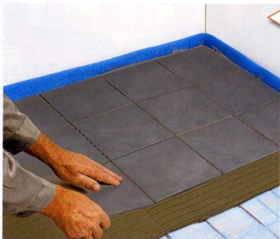
Укладка плитки на пластины с саморегулируемым кабелем T2Red (Raychem)
