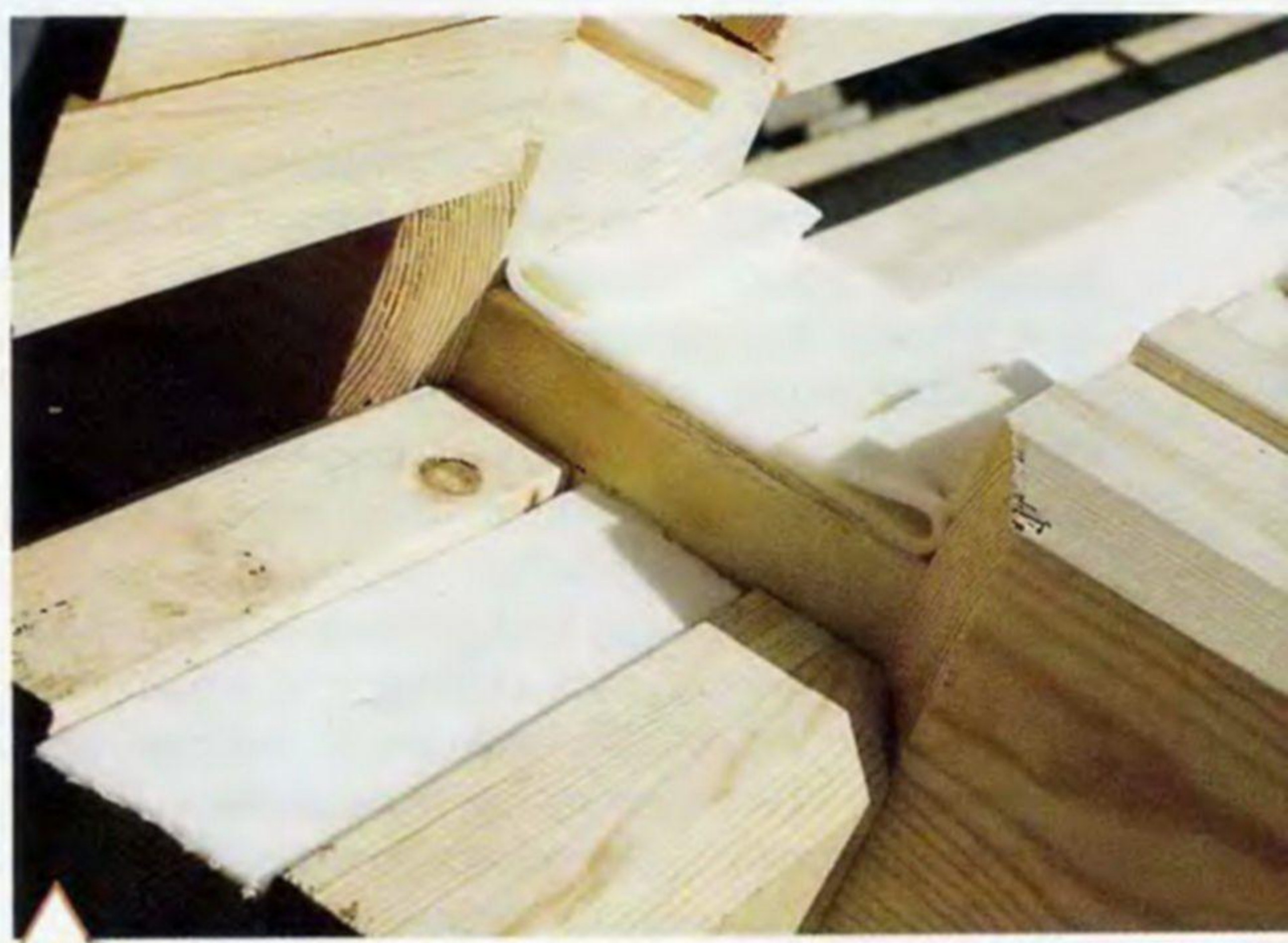
Укладка уплотнителя в продольный монтажный паз
