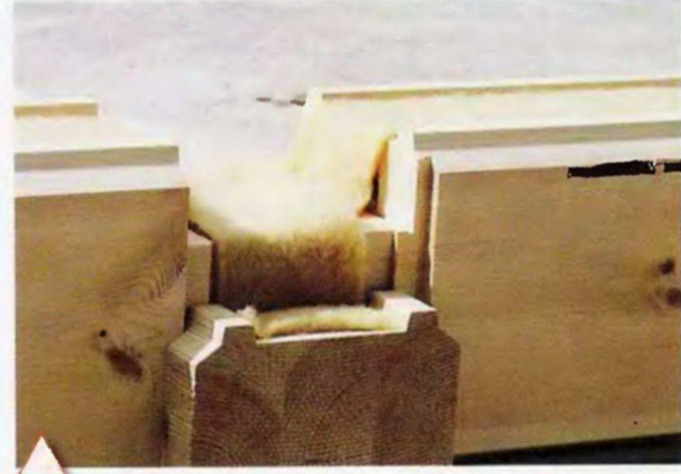
По такому принципу укладывается межвенцовый утеплитель (Vuokatti)
