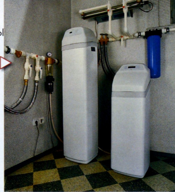
Система очистки воды. Состоит из фильтра механической очистки Honeywell, фильтра-обезжелезивателя EcoWaterSystem, умягчителя воды EcoWaterSystem, ультрафиолетового стерилизатора и угольного фильтра
