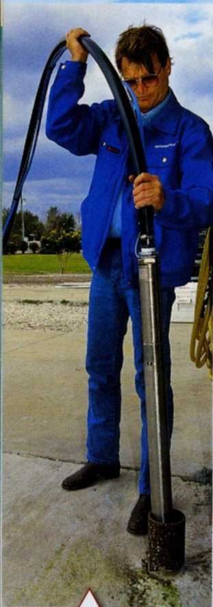
Установка скважинного насоса Grundfos
