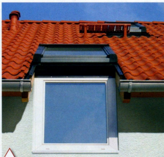
Соединение мансардного окна с фасадным элементом (ROTO)
