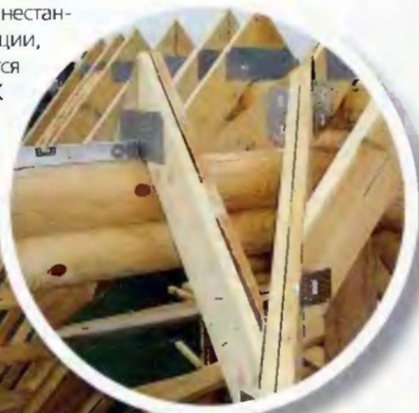
Стропильная конструкция (вид снаружи)
