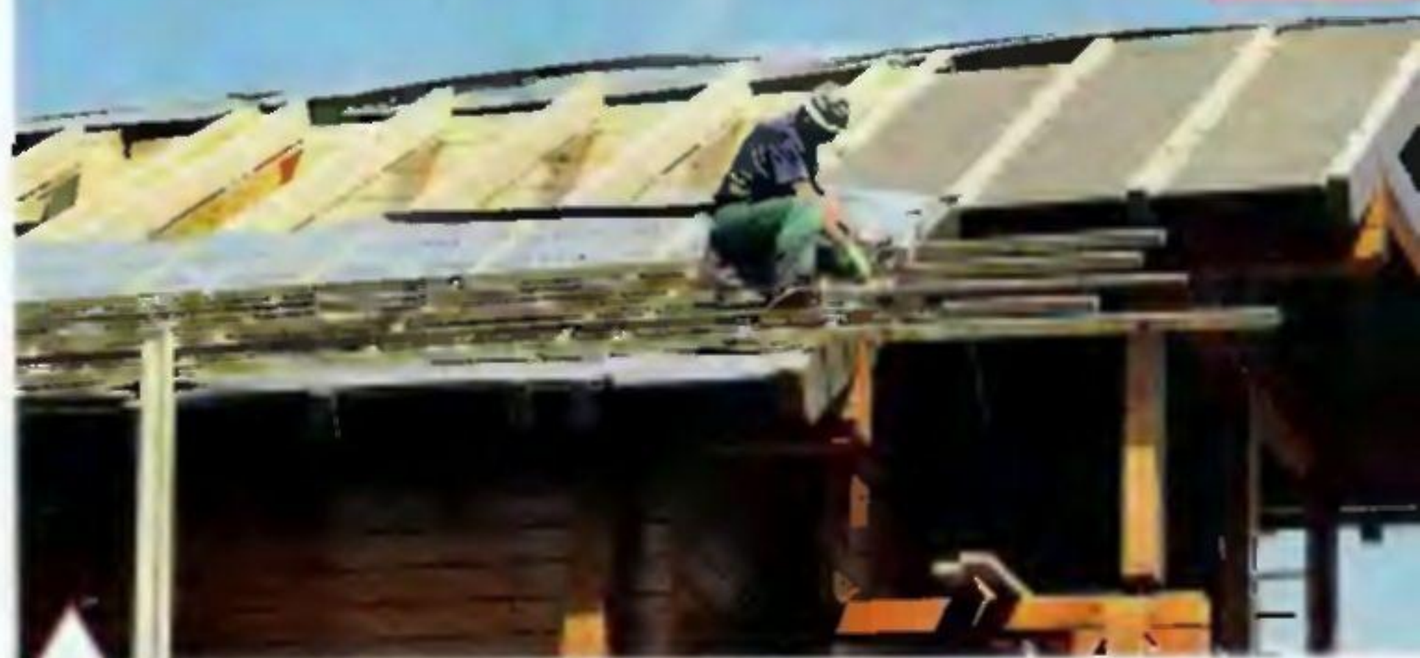
Укладка супердиффузионной мембраны DivoROLL (Tegola Canadese, Италия)
