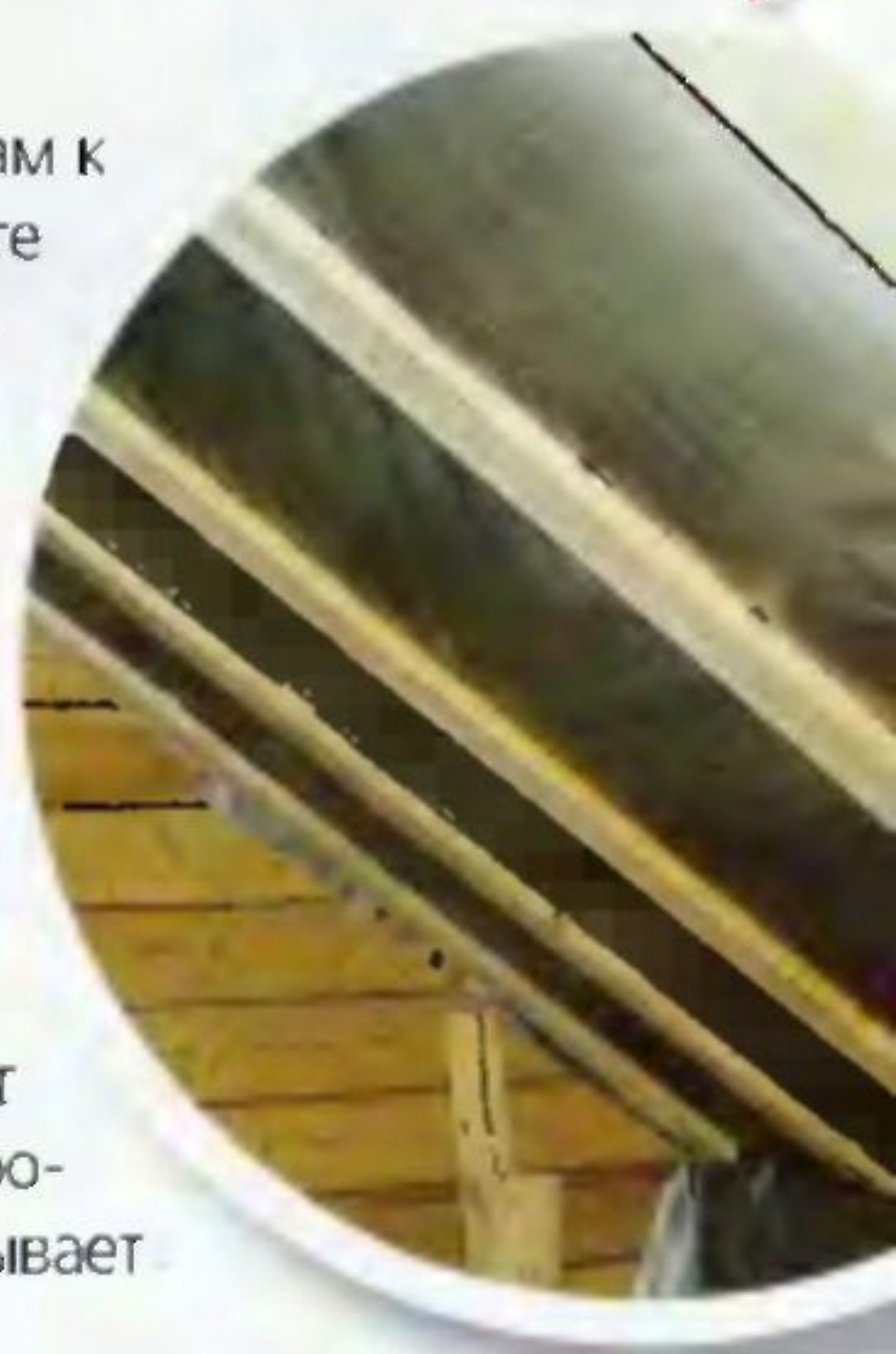
Утепление и пароизоляция мансардного этажа (ООО «Загородный дом»)
